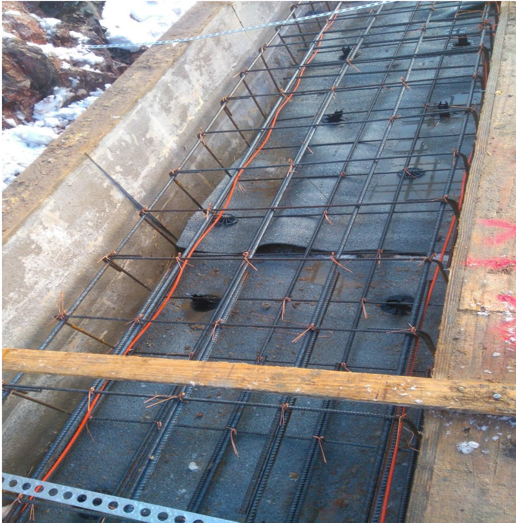
Kuva 7. Anturamuottiin asennetut lämmityskaapelit.
