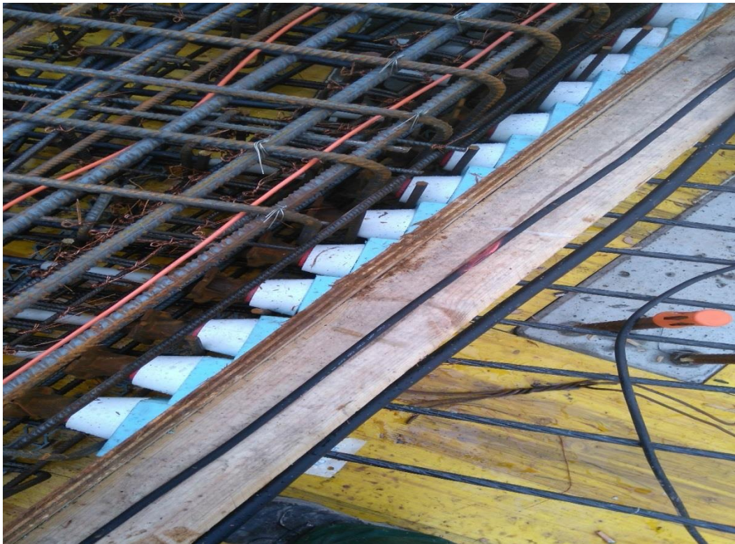
Kuva 3. Jännepunosten aktiivipäät kiinnitettyinä kuvassa.
