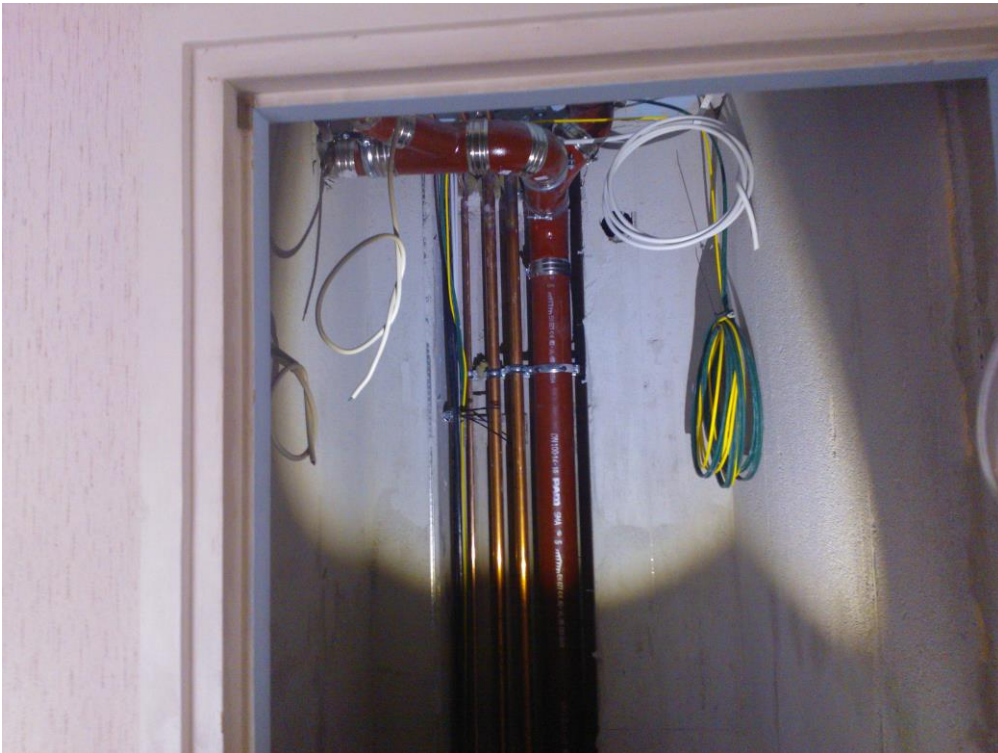
Kuva 6. Perinteisessä putkiremontissa valurautaviemäri, kupariset vesijohtoputket ja sähkönousut asennettuna vanhaan nousuhormiin. /8/
