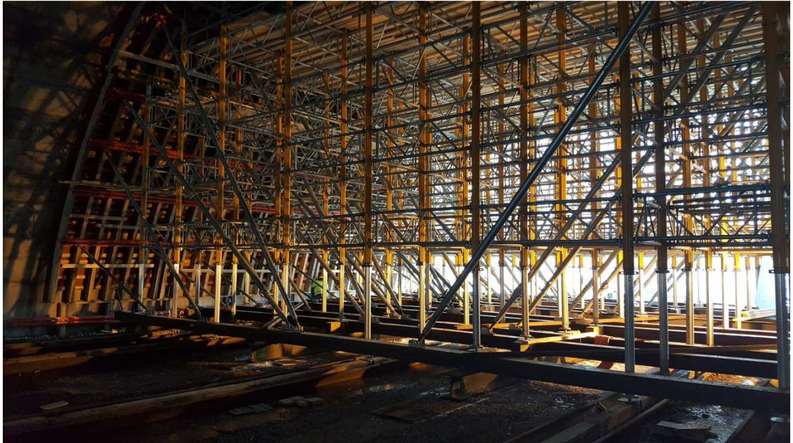
Kuva 3. Vihersillan rakentamisessa hyödynnetään telinejärjestelmää.
