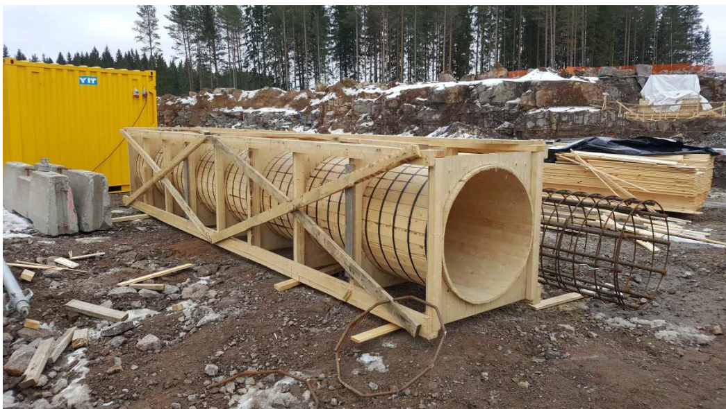
Kuva 4. Esivalmistettu pilarimuotti
