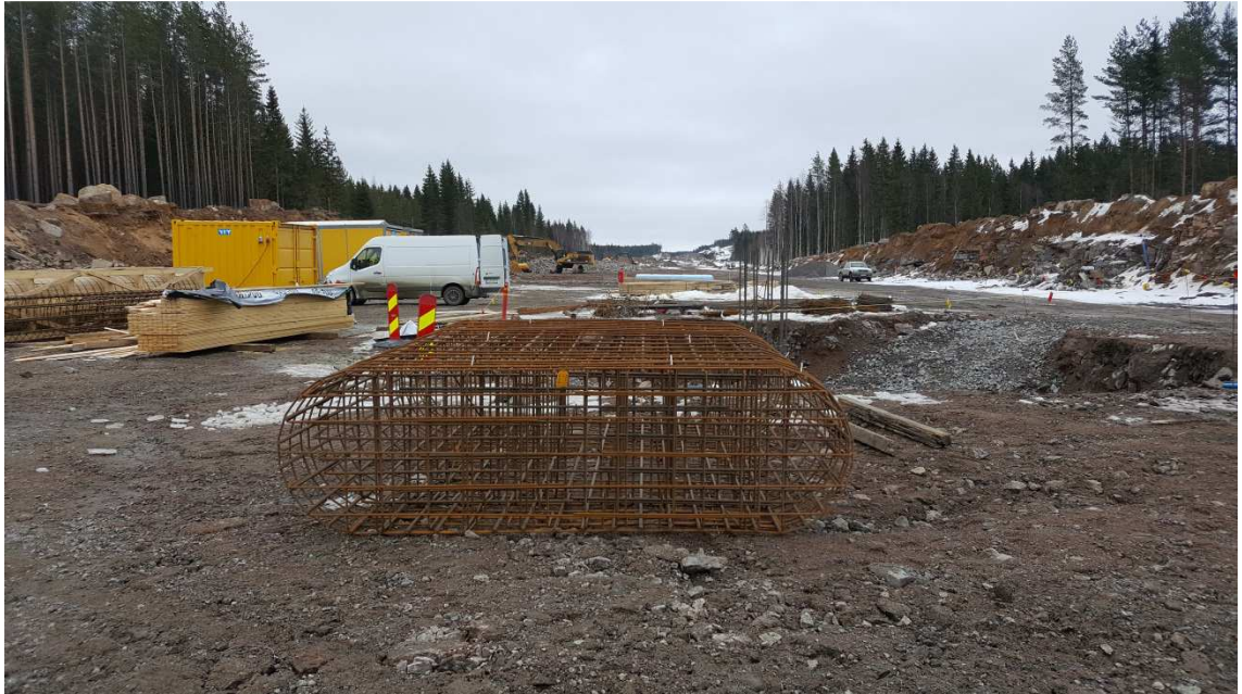
Kuva 1. Esivalmistettu siltapilarin raudoite
