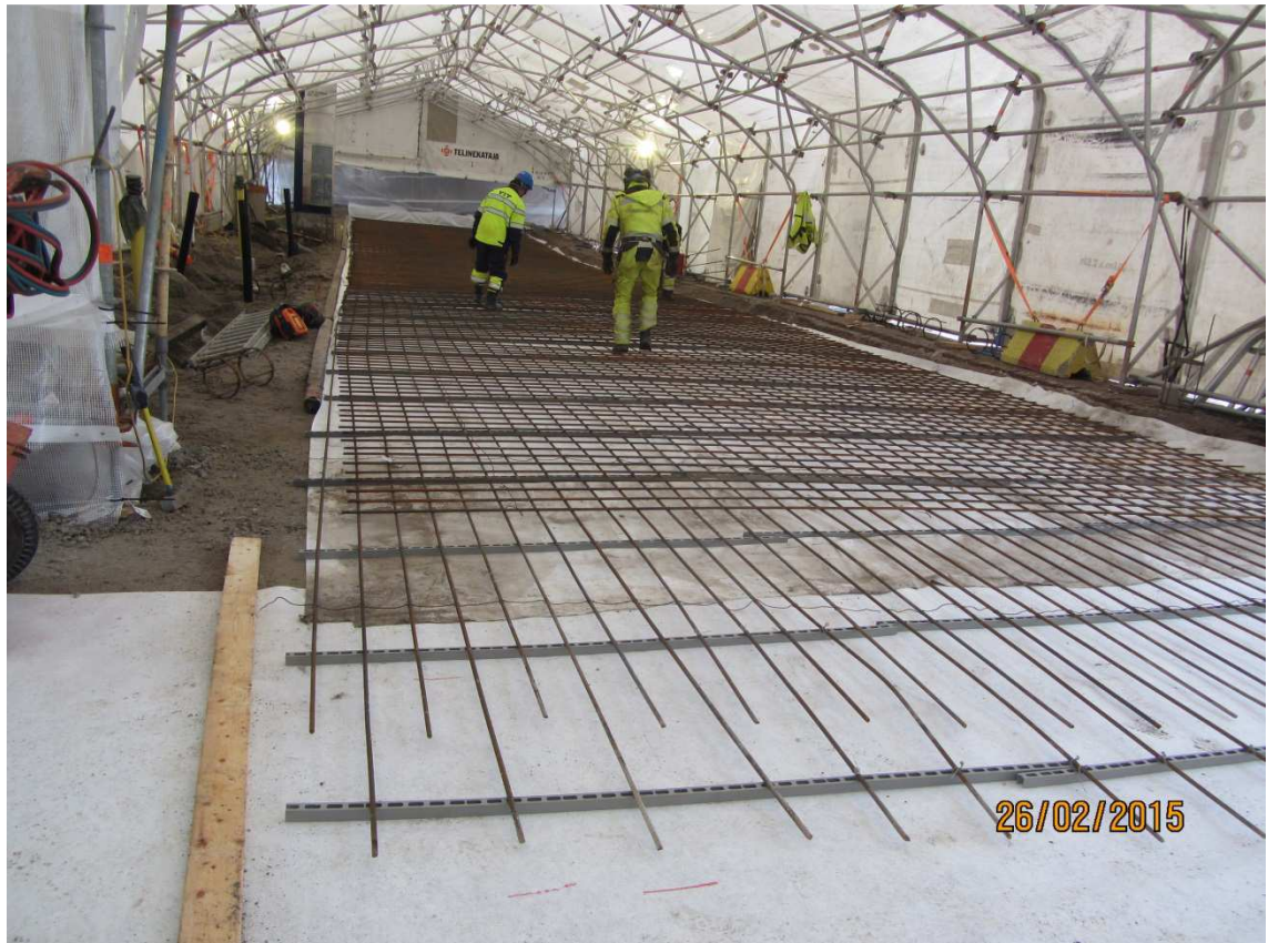
Kuva 2. Rullaraidoitteen toisen kerroksen asennus käynnissä
