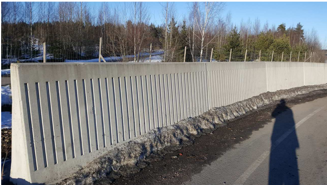
Kuva 5. Esivalmistettua betonista melukaidetta.
