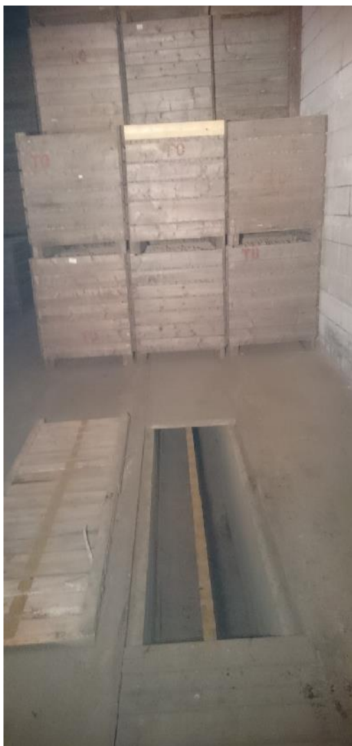
Bild 4. Ventilationskanal i lager 2 (Björnses 2017)
