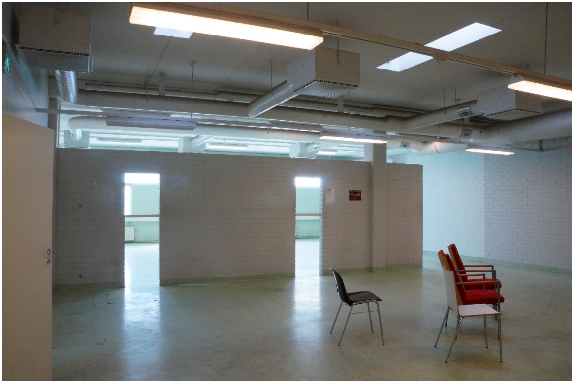
Kuva 2. Ylhäällä kuvassa tulevan monitiloimiston ikkunaseinä. Alhaalla kuvassa tilan vastakkaiselta seinältä avautuva näkymä. (Keisu, 2017.)
