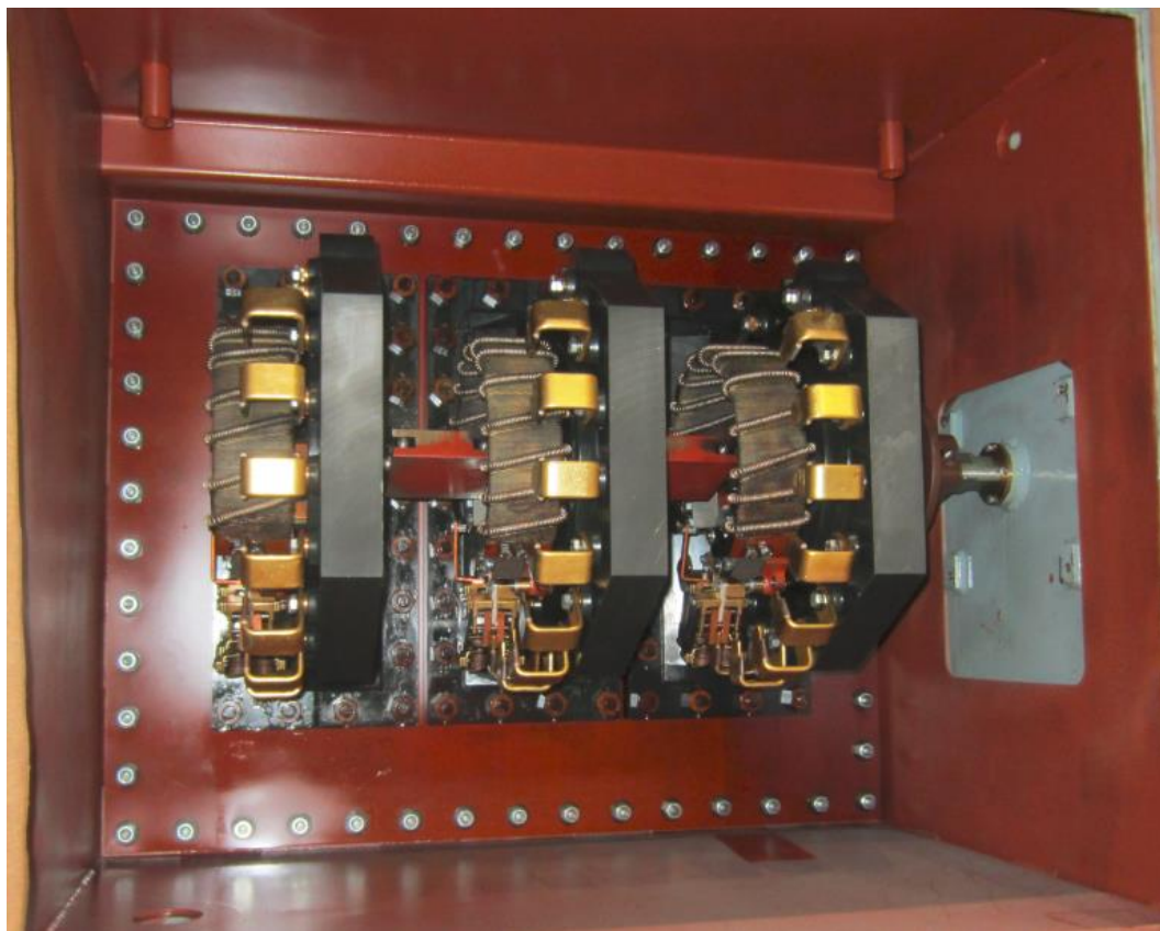
Kuva 9. UZ-tyyppin käämikytin
