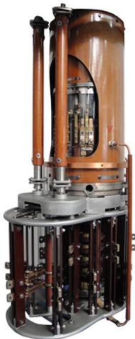
Kuva 14. D-tyyppin käämikytkin /14/
