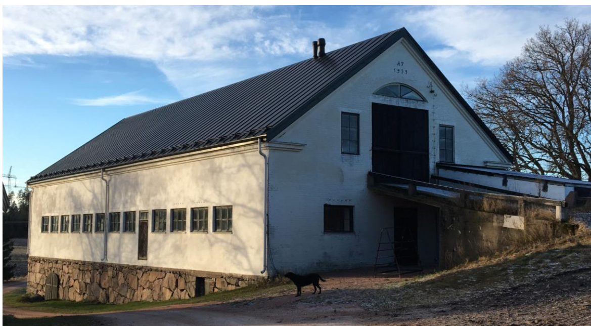
Figur 7 Karamellfabrikens framsida (bilden tagen 1 december 2016, Ingå).
