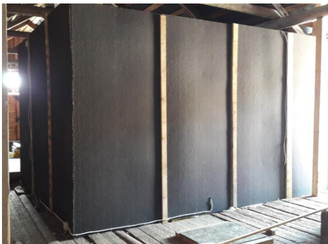
Figur 10 Takförhöjningen sett från vinden (bilden tagen 12 april 2017 av Terhi Karisalmi, Jämsä).
