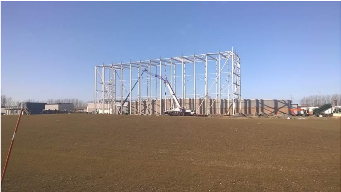
Figur 15 Kyllager av stål. (foto John Sundblom, 2015)
