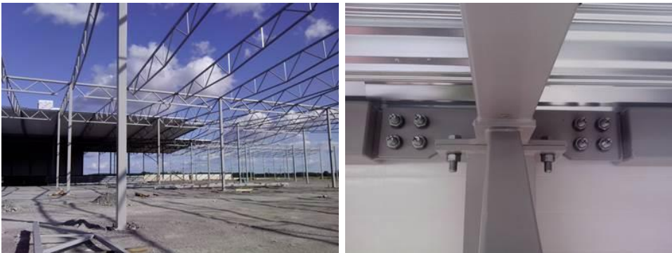
Figur 14 Bilden till vänster är färdigt svetsade fackverk från fabriken och bilden till höger är ett bultförband som de (Ruukki) använder. (foto John Sundblom, 2015)
