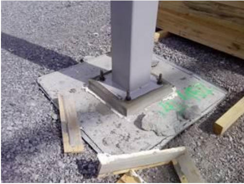
Figur 13 Stålpelare på plats vid ett hallbygge. (foto John Sundblom, 2015)
