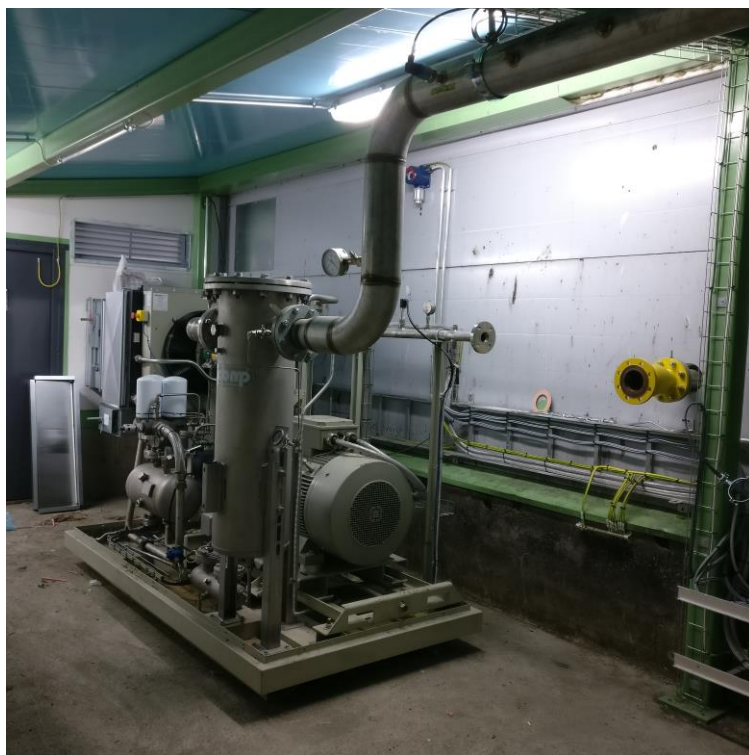
Kuva 6. Kompressori 14-FA-02 asennettuna (Juhala 2017)
