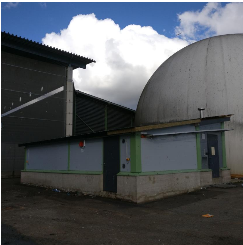
Kuva 2. Kaasunpaineistustila työn jälkeen (Juhala 2017)
