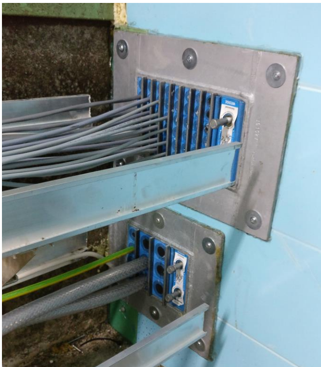
Kuva 5. Roxtec'in läpivientilaipat asennettuna (Juhala 2017)
