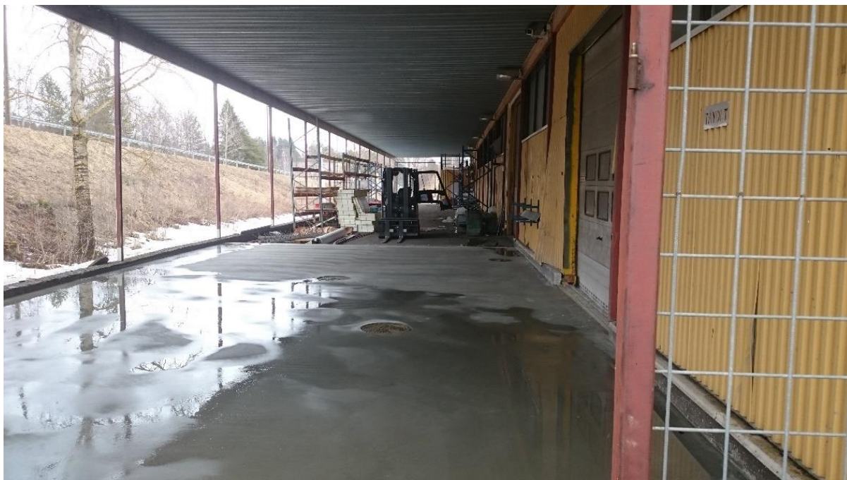
KUVA 19. Tuleva lämmin varastotila (Kuva Mika Latvanen).
