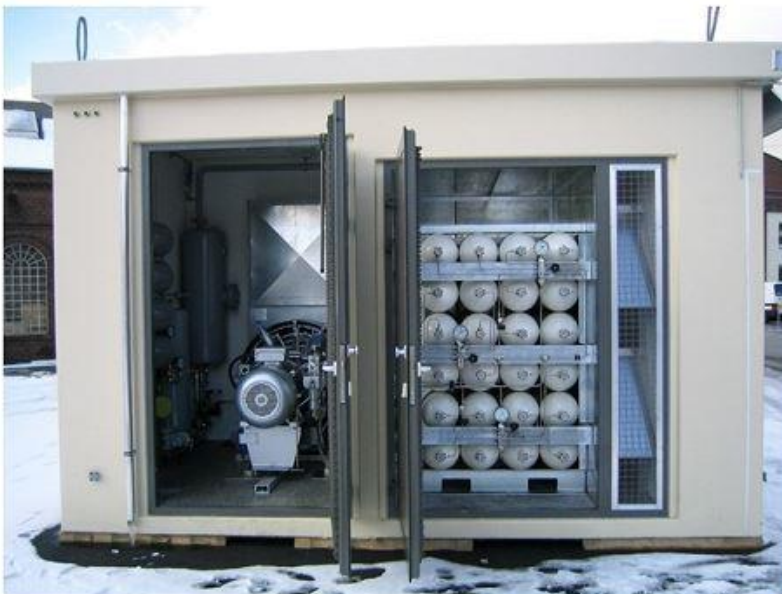
KUVIO 12. Biokaasuvarasto liikennekäyttöön, kompressoritila vasemmalla
