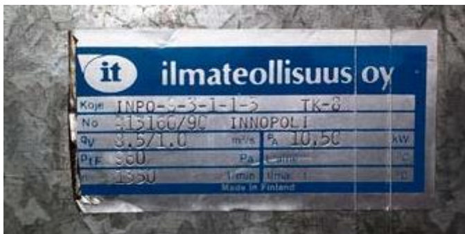
KUVA 24. Puhaltimen laitekilpi, josta käy ilmi ilmavirta ja paineenkorotus ja akseliteho. (8.)
