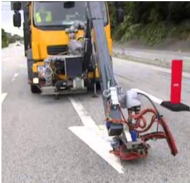
Kuva 15. Tienmaalausrobotti (Lähde. Youtube, RME Channel)
