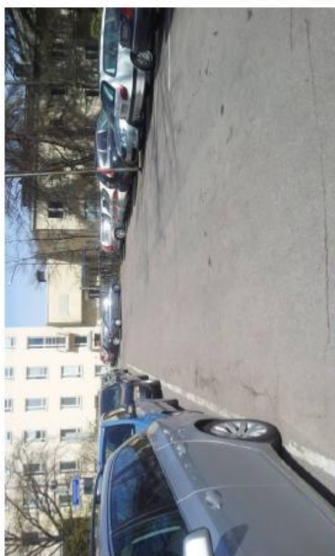
Kuva 106. Kuoppia sekä pitkittäis- ja poikittshalkeamia.
