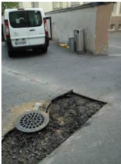
Kuva 9. Vaurioitunut päällyste poistettu korjattavalta alueelta. (Suotula, 2015).
