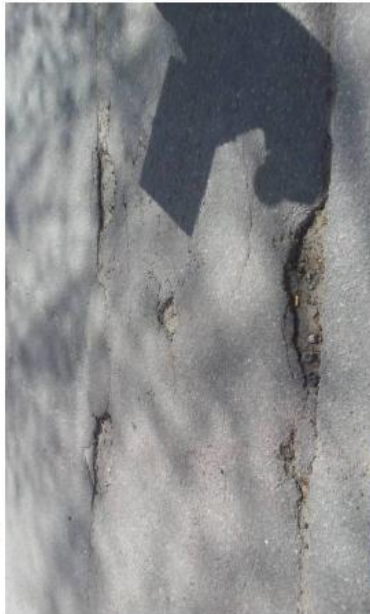
Kuva 96. Kuoppia sekä halkeamia.
