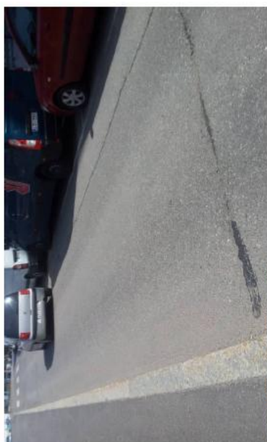
Kuva 63. Poikittais- ja pitkittäshalkeamat.
