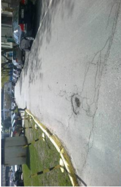
Kuva 113. Kuoppia sekä halkeamia.
