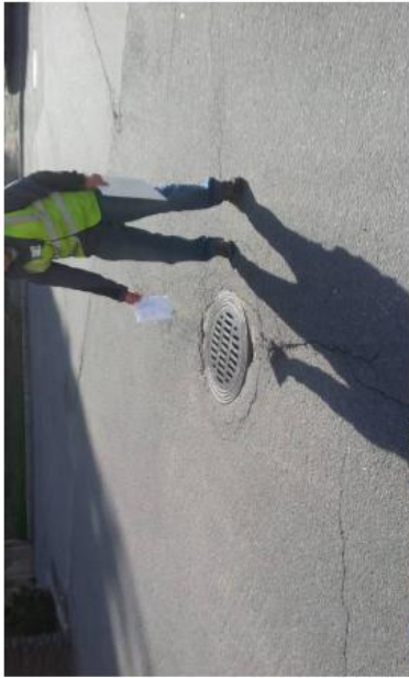
Kuva 23. Asfaltti halki kaivon ympäriltä.
