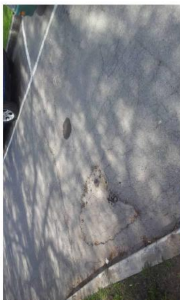
Kuva 91. Kuoppia sekä halkeamia.
