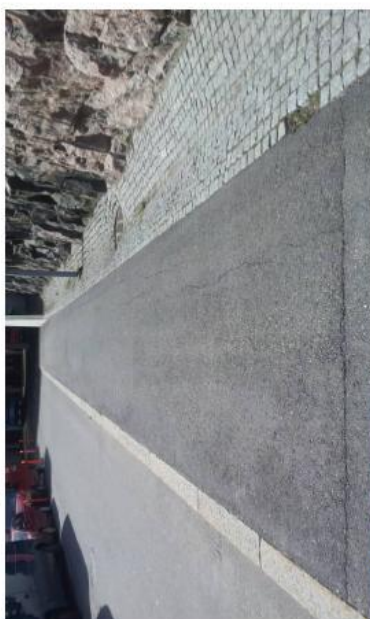
Kuva 63. Poikittais- ja pitkittäshalkeamat.
