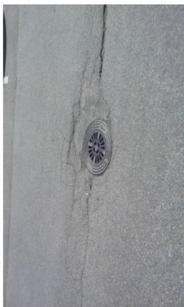
Kuva 55. Kuoppia ja halkeamia.
