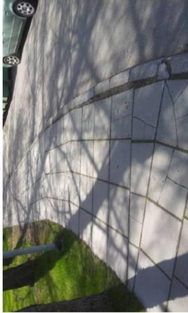
Kuva 98. Laatoitus rikkoutunut.
