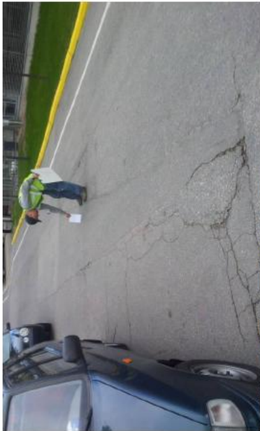
Kuva 11. Verkko- ja polkittajahakama, kuoppia ja palikkaus.
