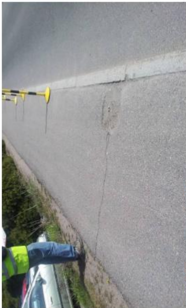
Kuva 67. Polkittaaialkeama sekä kuoppa.
