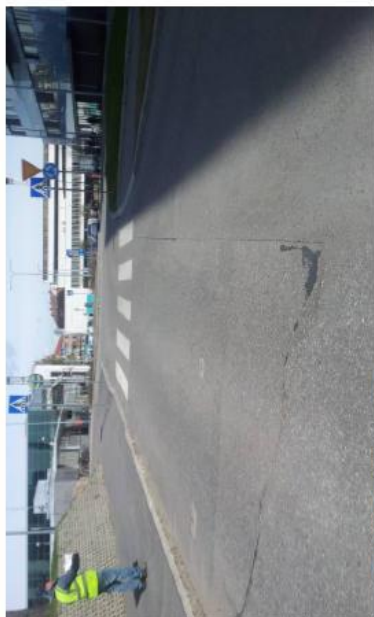
Kuva 65. Poikittais- ja pitkittäshalkeamat.
