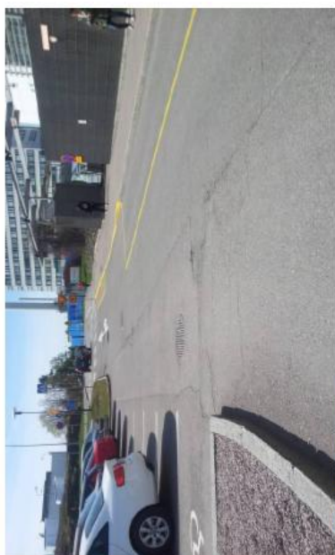
Kuva 55. Kuoppia ja halkeamia.
