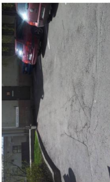
Kuva 91. Kuoppia sekä halkeamia.
