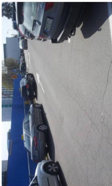
Kuva 49. Halkoamia asfaltissa.
