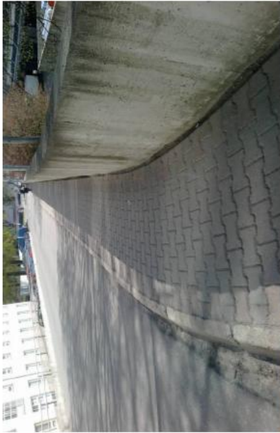
Kuva 111. Laatoitus kuopilla.
