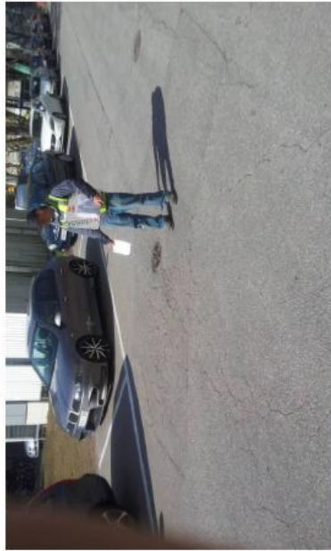
Kuva 23. Asfaltti halki kaivon ympäriltä.
