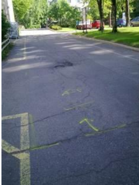
Kuva 44. Tukholmankadun liittymä (Suotula, 2012).
