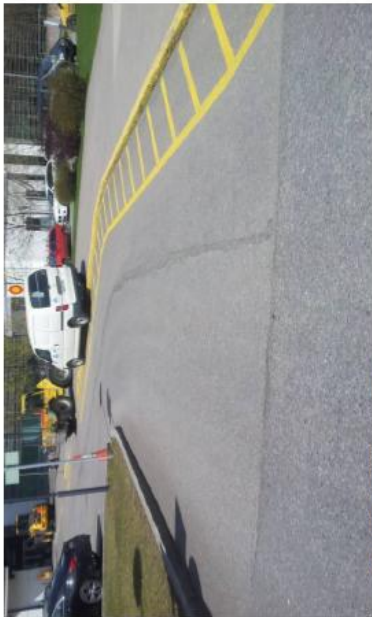
Kuva 69. Polkittaa- ja pitkittäishalkaumat.
