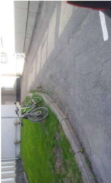
Kuva 95. Kuoppia sekä halkeamia.
