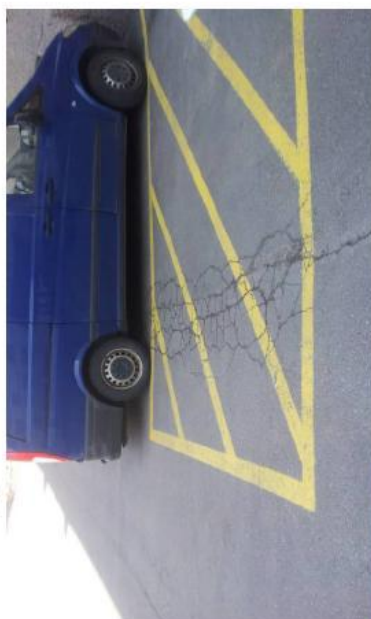
Kuva 87. Pitkittäis- ja poikittais halkeamat
