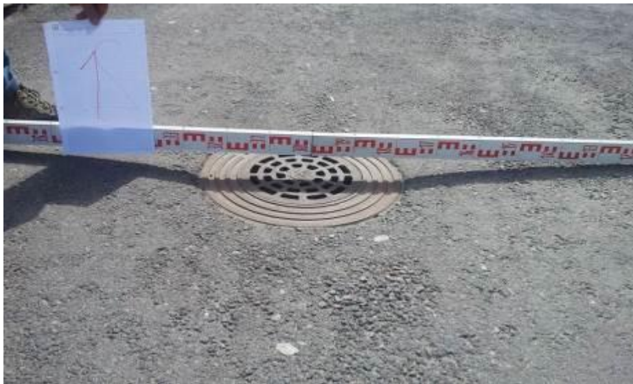
Kuva 48. Kaivon korkeusaseman inventointi (Pohjatekniikka, 2014).
