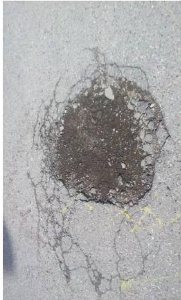
Kuva 176 Halkeajilla noin 80cm ja 8cm syvä kuoppa.
