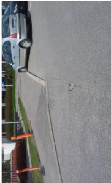
Kuva 41. Kuoppa asfaltissa sekä reunakivi uponnut.
