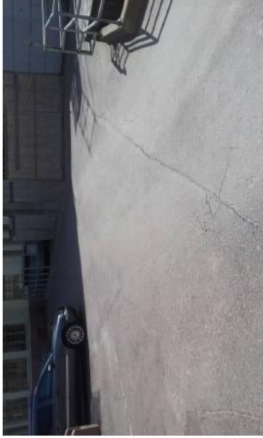
Kuva 85. Poikittais halkeama.
