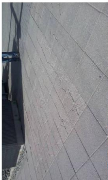
Kuva 57. Laatoitus rikkoutunut.
