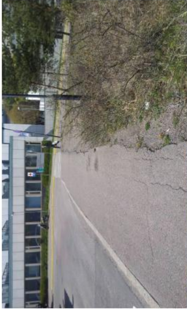
Kuva 53. Aistaitin reuna rikkoutunut sekä halkeamia.
