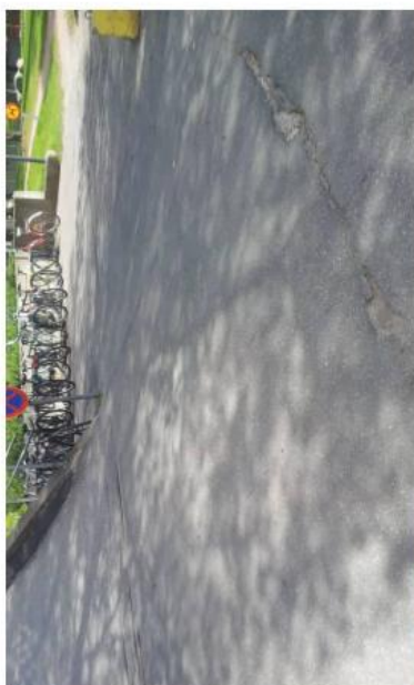
Kuva 104. Poikittaisia halkeamia.
