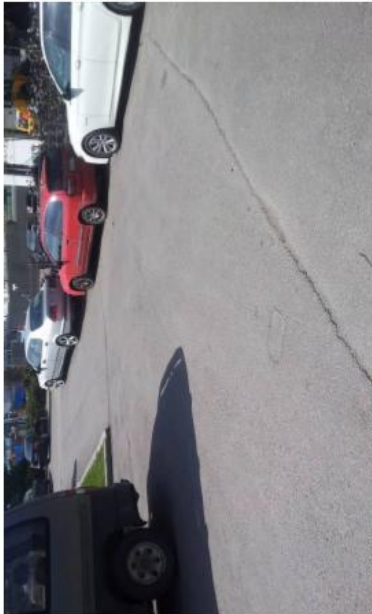
Kuva 71. Halkeamia sekä pieniä kuoppia.
