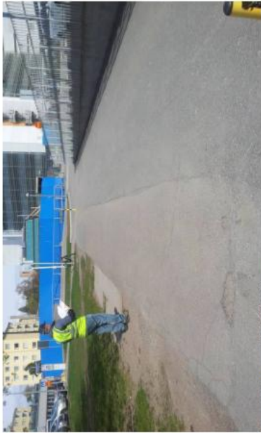
Kuva 43. Kuoppia sekä pölyttämälukka.
