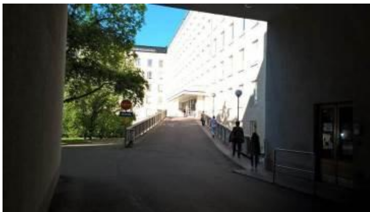
Kuva 13. Naistenklinikan pääsisäänkäynti ajorampeineen (Suotula, 2016).
