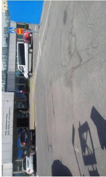
Kuva 46. Halkeamia asfaltissa.
