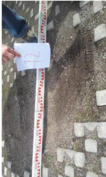
Kuva 11. Verkko- ja polkittajahakama, kuoppia ja palikkaus.
