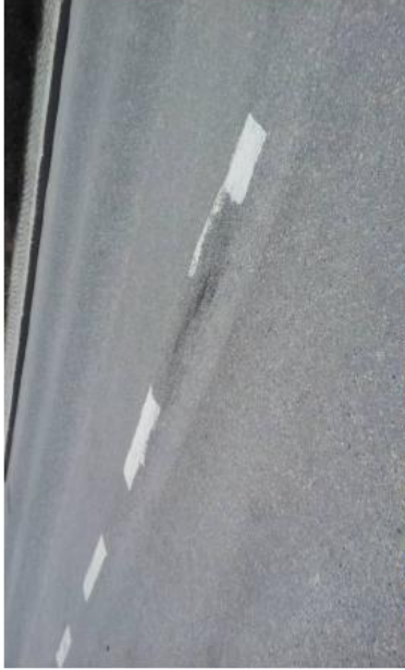
Kuva 73. Noin 3,5m pitkä, 30cm leveä ja 10cm syvä kuoppa.
