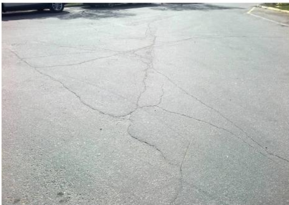
Kuva 116. Halkeamia sekä kuoppia.
