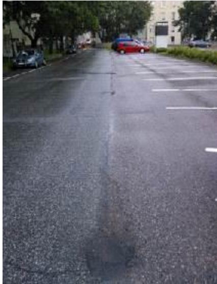
Kuva 10. Kannukaatosaumaus vuonna 2015 palvelukeskuksen puoleisella ajoradalla (Suotula, 2015).
