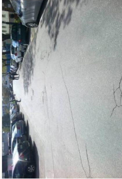
Kuva 113. Kuoppia sekä halkeamia.
