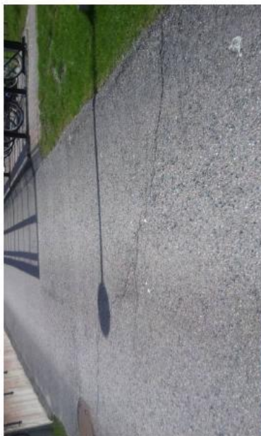
Kuva 65. Poikittais- ja pitkittäshalkeamat.
