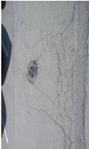
Kuva 69. Polkittaa- ja pitkittäishalkaumat.
