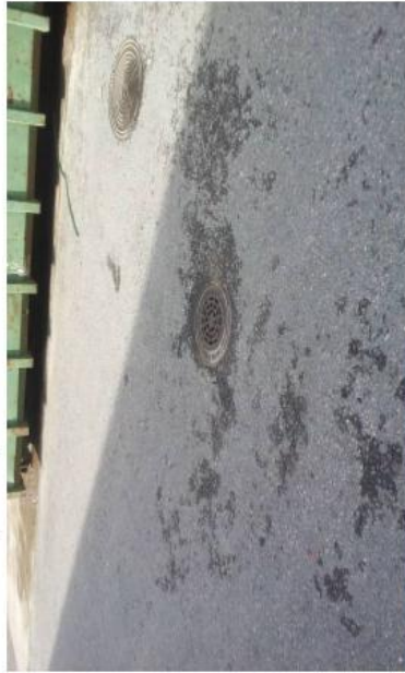
Kuva 165. Kaivo kuopassa sekä pikittälshalkaama.
