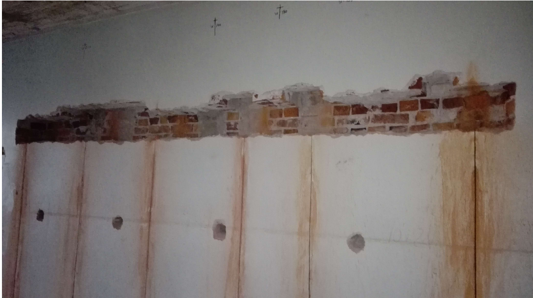
Kuva 2. Uusien aukkojen ylityspalkeille tehdyt urat.
