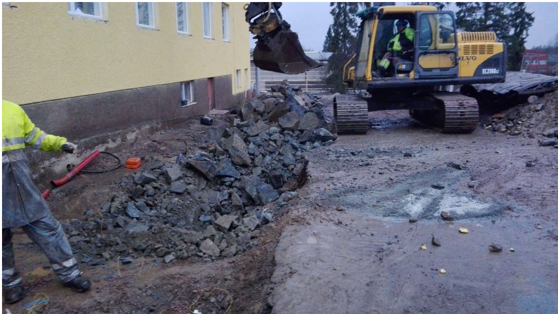
Kuva 4. Sadevesi linjojen louhintaa.
