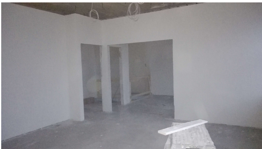
kuva 1. Kahi runkopontti väliseinää.
