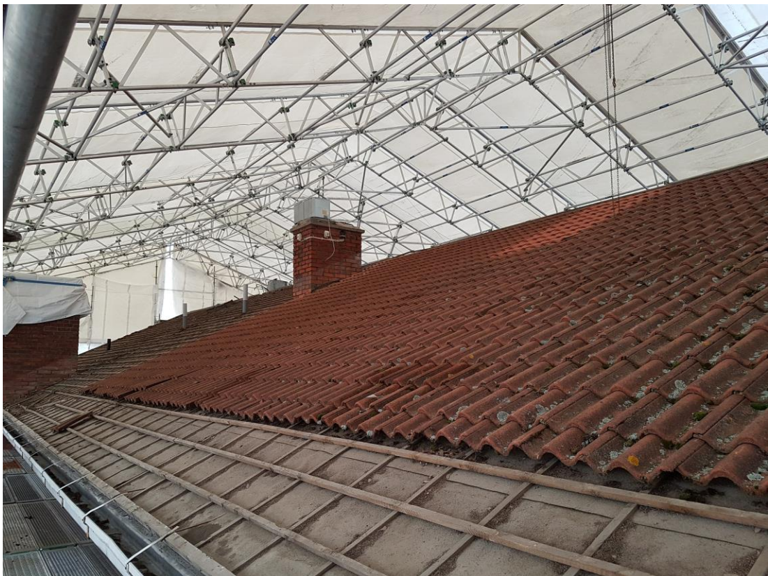
Kuva 5. Päärnäisten päiväkodin huputus sisältä.
