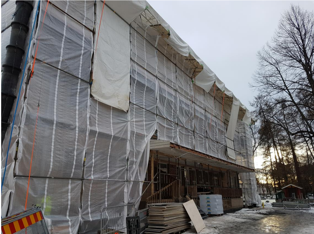
Kuva 4. Päärnäisten päiväkodin huputus ulkoa.
