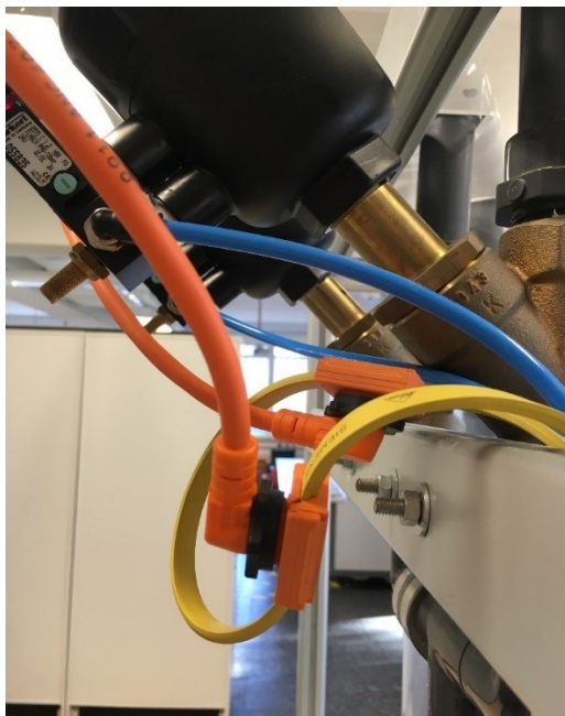
Kuva 16. Liityntä runkokaapelista toimilaitteelle puristusliittimen avulla.
