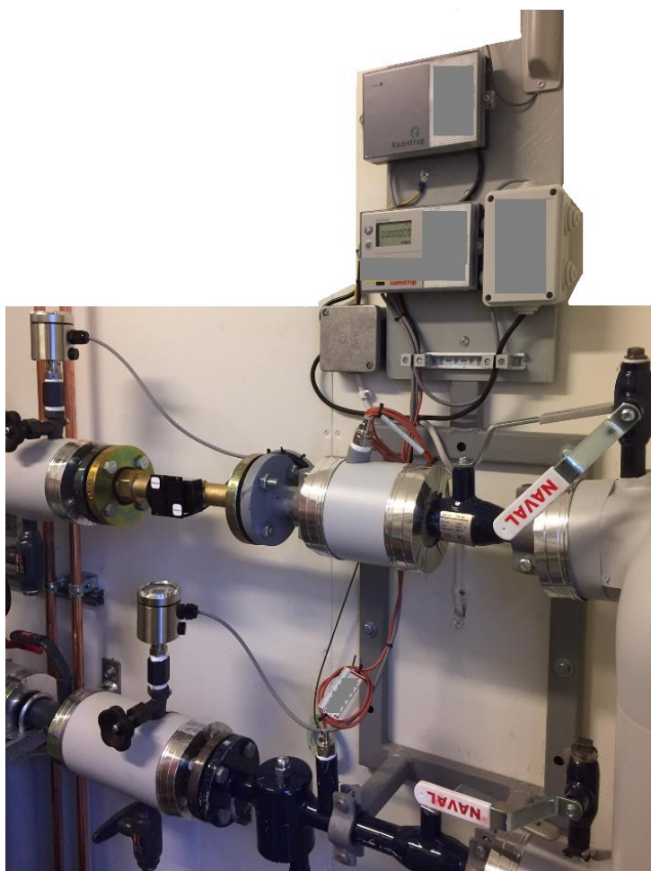
Kuva 41. Paineanturit asennettuna ja mittaus valmiina kohteessa 4.
