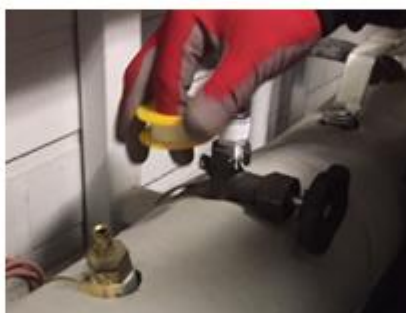
Kuva 7. Kierrelitosten tiivistäminen.
