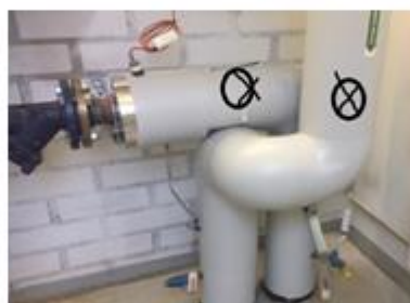
Kuva 2. Suunnitelma paineantureiden asennusyhteiden kohdista.
