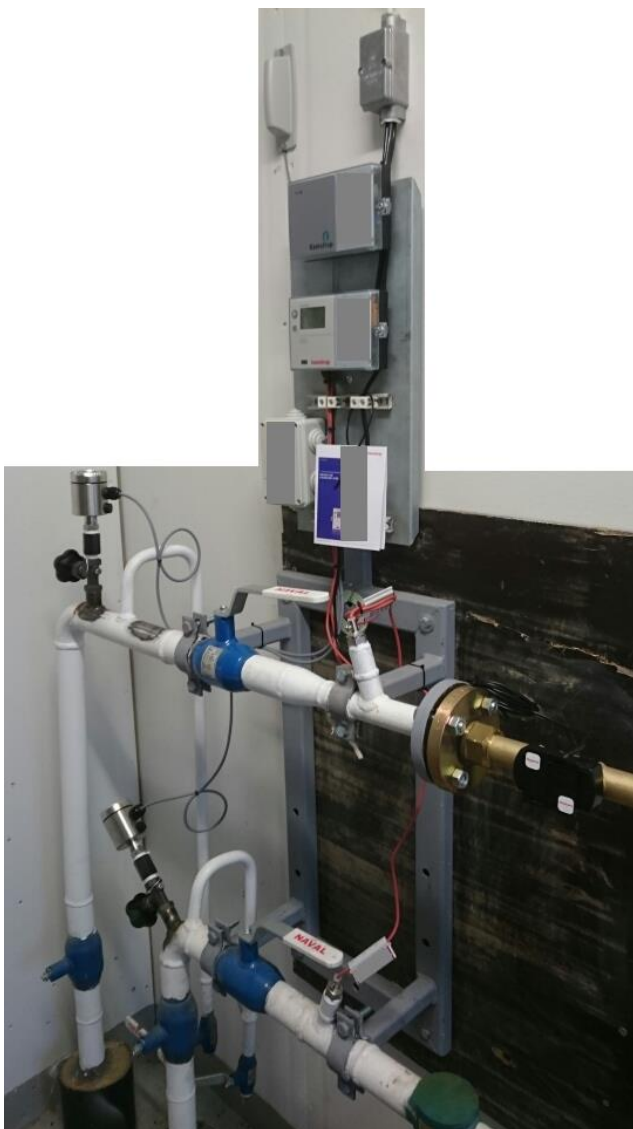
Kuva 44. Paineanturit asennettuna.
