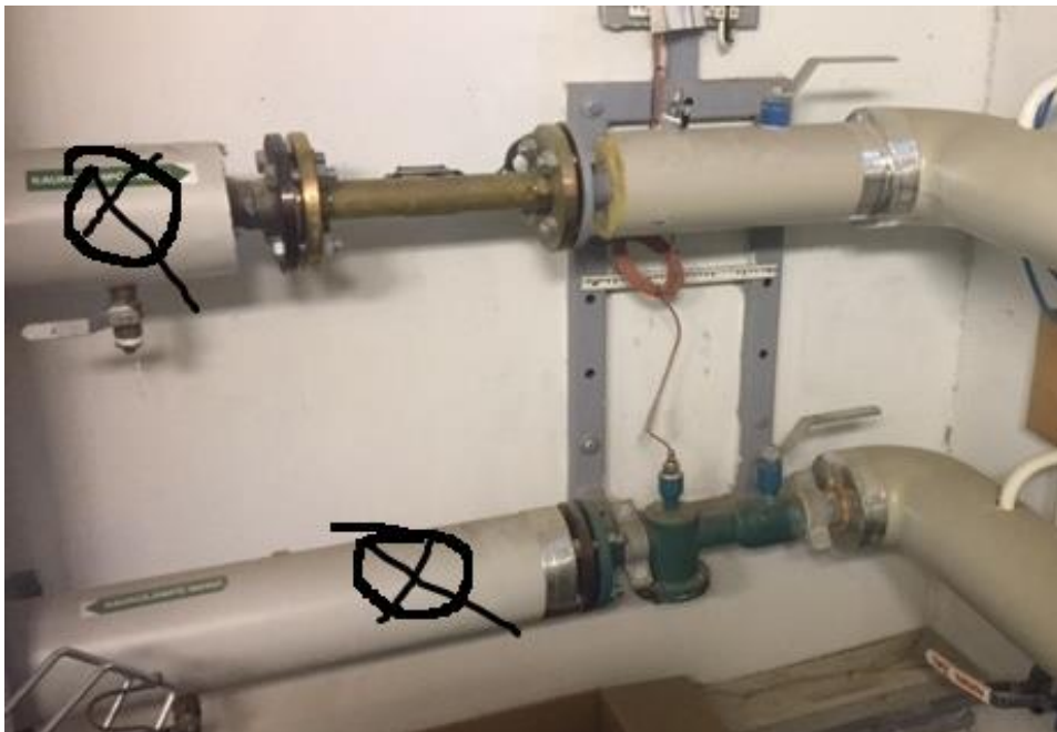
Kuva 14. Katselmus tehty ja asennusyhteiden paikat on merkittynä kohteessa 5.
