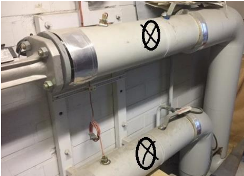
Kuva 12. Paineantureiden asennuspaikan katselmus kohteessa 3.
