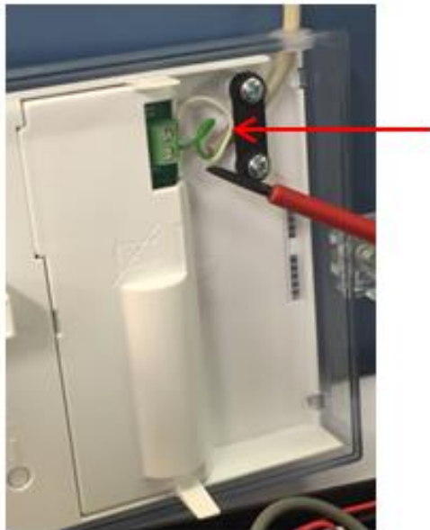
Kuva 19. M-Bus-johdon irrotus meneillään.
