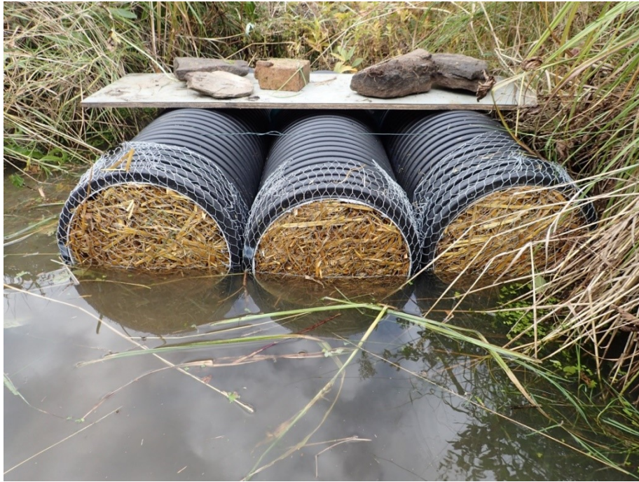
Kuva 14. Olkibiosuotimet kiinnitettiin rinnakkain toisiinsa, laskettiin Riuskanojaan avoin suu yläjuoksua kohti ja suodinsetin päälle asetettiin painoksi kiviä. (Kuva: P. Lohela)
