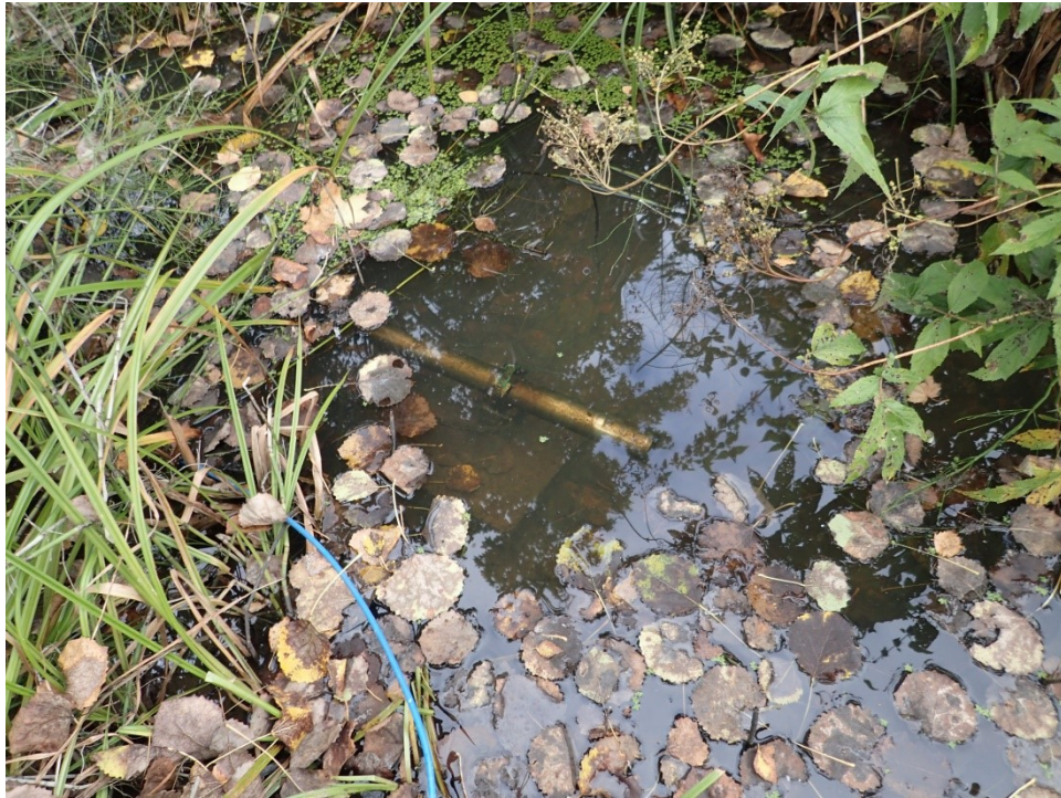
Kuva 10. Riuskanojaan sijoitettu online-mittari. (Kuva: P. Lohela)
