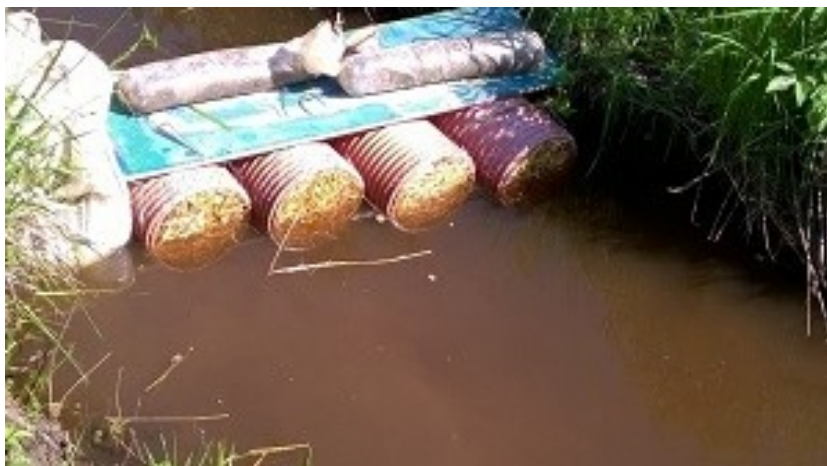
Kuva 9. Riuskanojaan asennetut ojarumpupätkät, jotka oli täytetty olkimassalla (HAMK n.d.).
