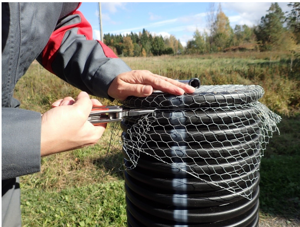
Kuva 12. Olkibiosuotimena käytetyn ojarummun toinen pää suljettiin kanaverkolla ja kiristettiin paikoilleen rautalangalla. (Kuva: P. Lohela)
