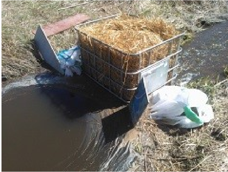
Kuva 8. Kanaverkolla vuorattu ja oljilla täytetty IBC-kontti Riuskanojassa (HAMK n.d.).
