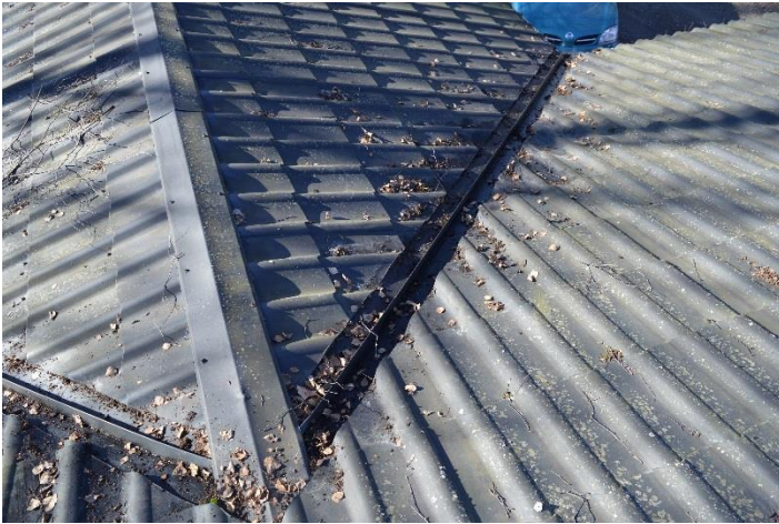
Kuva 11. Vesikaton jiiri silmämääräisesti hyvässä kunnossa.
