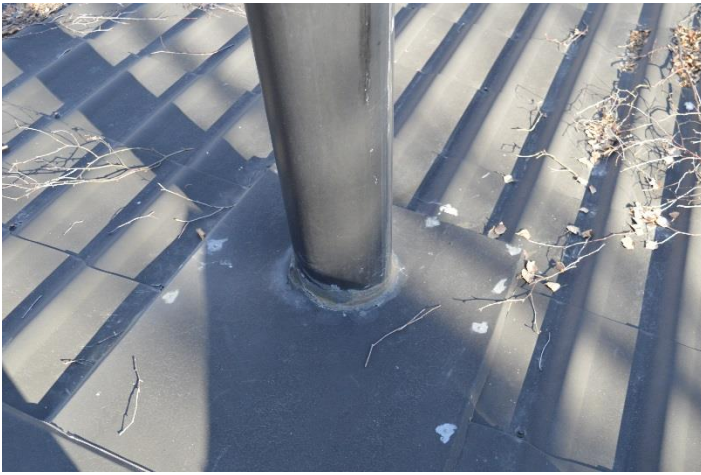
Kuva 10. Läpivienti vesikatolla tiivis.
