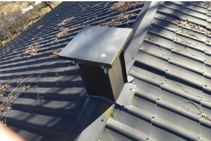
Kuva 9. Vesikaton yleiskunto hyvä. Katon läpiviennit tiiviit.
