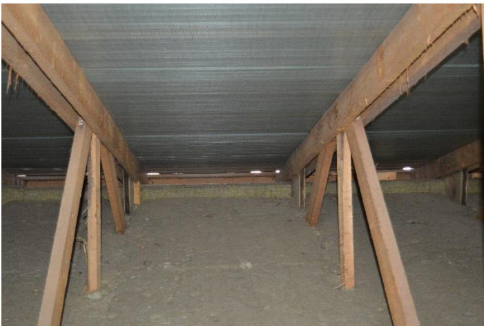
Kuva 12. Yläpohjan tuuletus kunnossa. Aluskate ehjä ja tiukalla.
