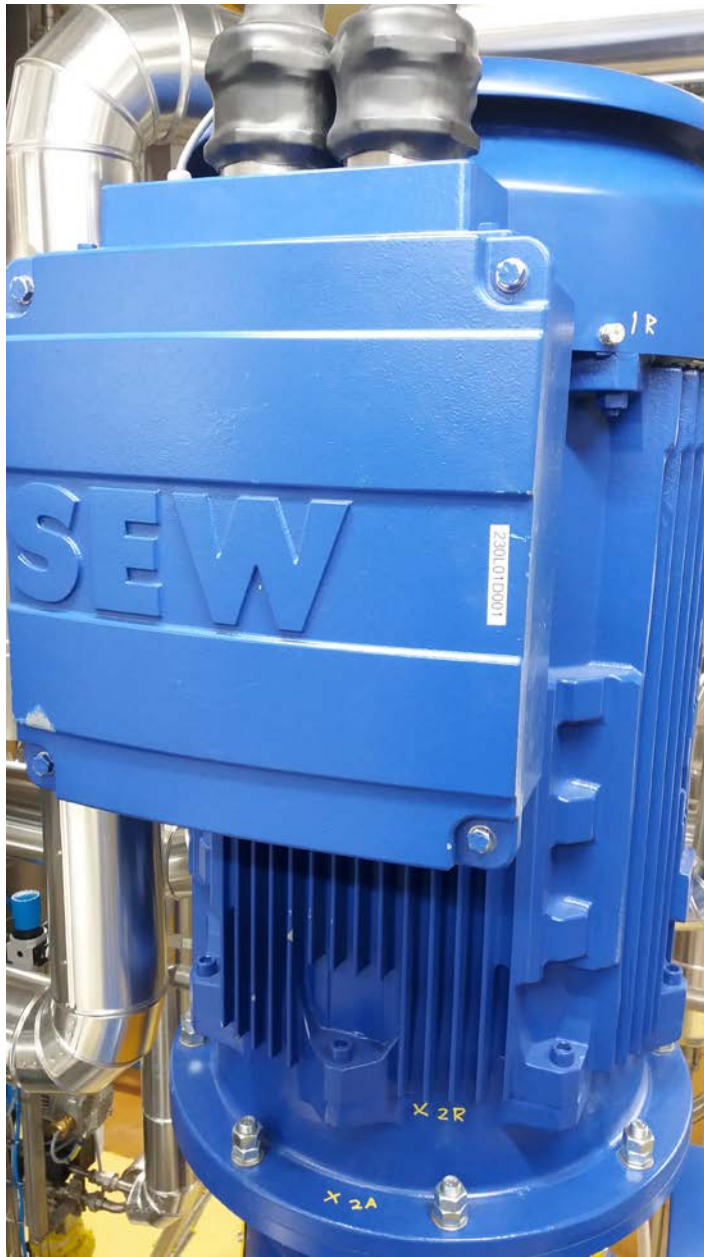
Kuva 11. Sähköpäämoottorin mittauspisteet.
