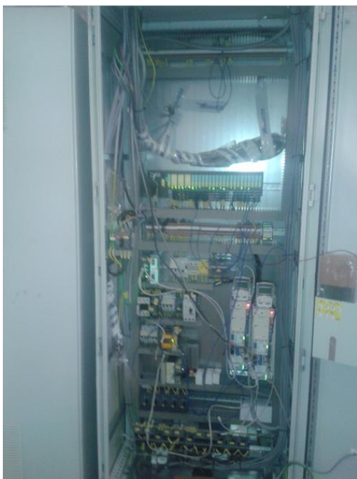
Kuva 21. Uusi kaappi kytkettynä
