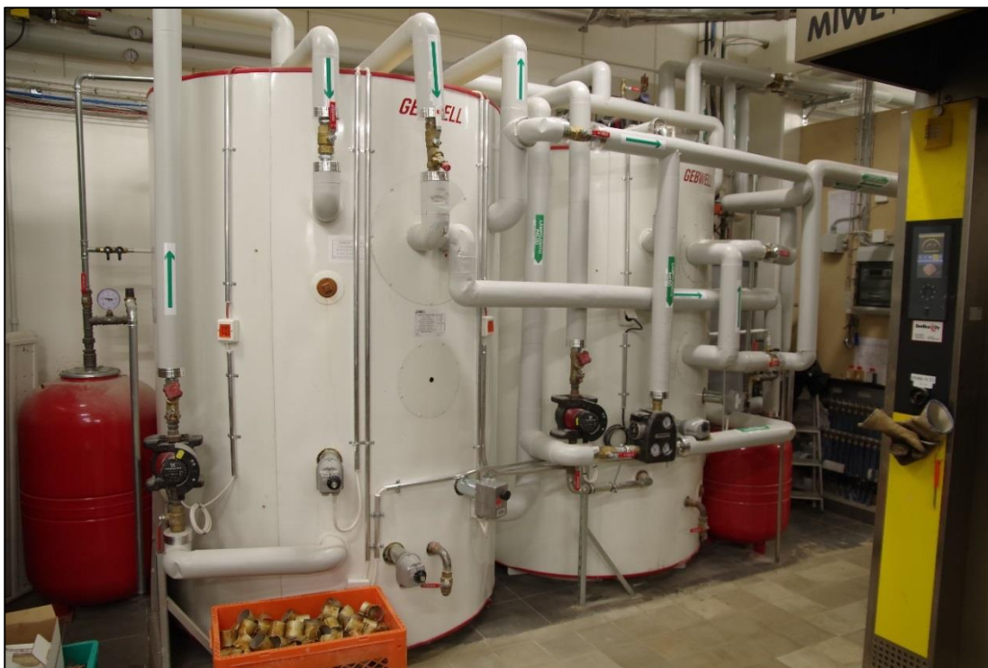
Bild 8. Gebwells ackumulatortankar. Foto: Niklas Wiberg.
