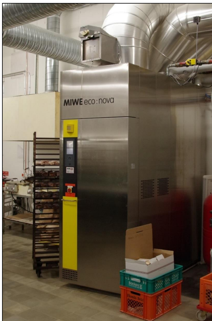
Bild 3. MIWE eco:nova värmeåtervinningsväxlare. Foto: Niklas Wiberg.
