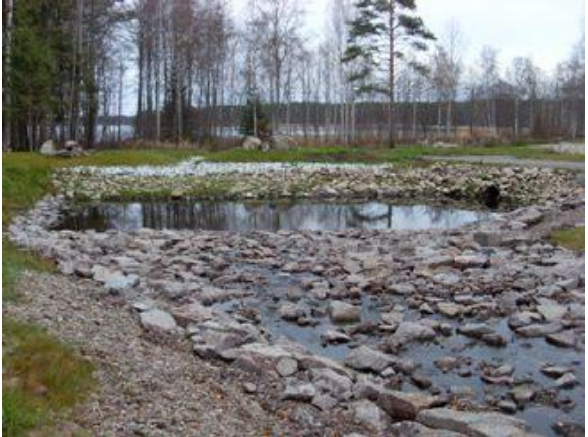
Kuva 9. Lappeenrannan Sammonlahdessa sijaitseva hulevesikosteikko (Lukkari 2015).
