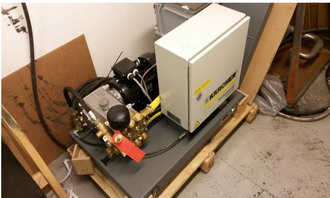
Kuva 22 Sumutusjärjestelmän korkeapainepumppu
