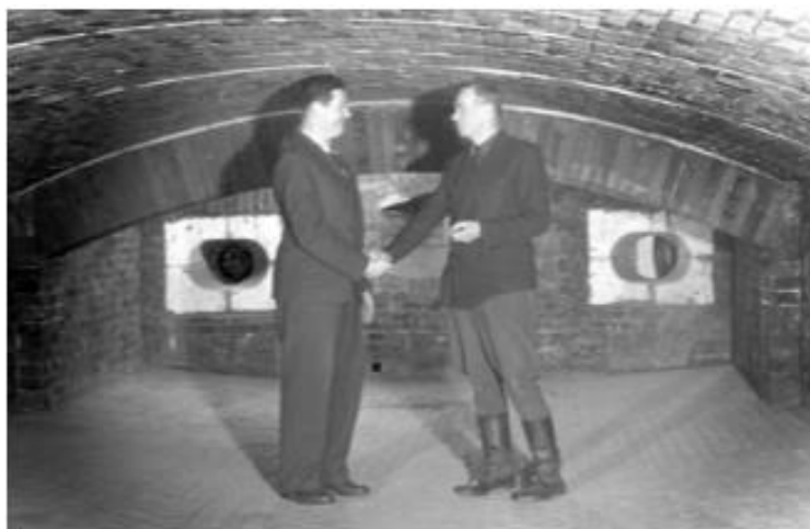
Kuva 6 Kupariliekkisulatusuunin käyttöönotto (Boliden, www-sivut, 2016)
