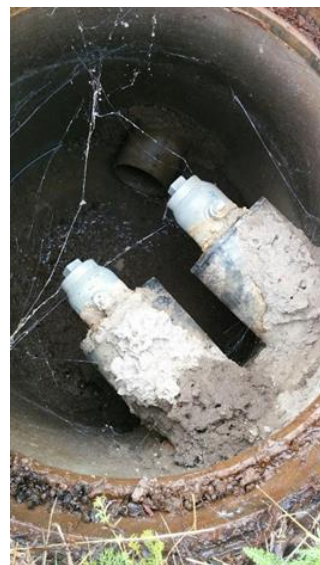
Kuva 24. Tyhjennys, pohjalla näkyy viemäriin johdettu putki
