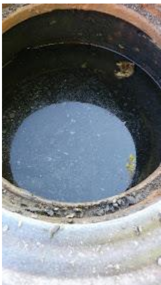
Kuva 25. Venttiili ei edes pilkota veden alta, mutta kyllä se siellä on.
