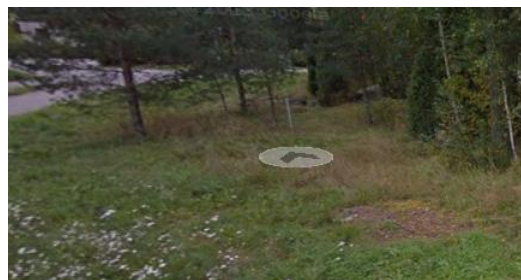
Kuva 8. Venttiilit merkitty putkella (harmaa) nuolen edessä
