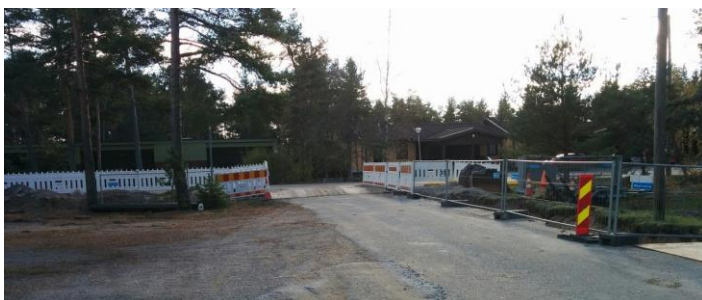
Kuva 35. Tässä on hyvin aidattua kaukolämpötyömaata
