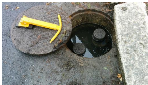
Kuva 27. Vesi valuu tähän herkästi ja se on ollut jossain vaiheessa kanteen saakka. Suojahatun pitävyys on tärkeää, ettei vesi pääse ruostuttamaan / hapettamaan venttiiliä
