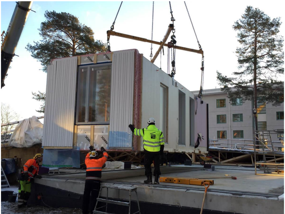
Kuva 2. Tilaelementin asennus As Oy Joensuun Pihapetäjällä.
