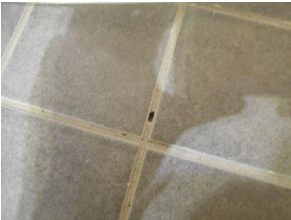
Kuva 7. Saumauksessa oleva reikä, joka on tullut huonosta sauma-aineen levityksestä tai liian voimakkaasta sauma-aineen sekoituksesta. (Hanhinen Ville 2015)
