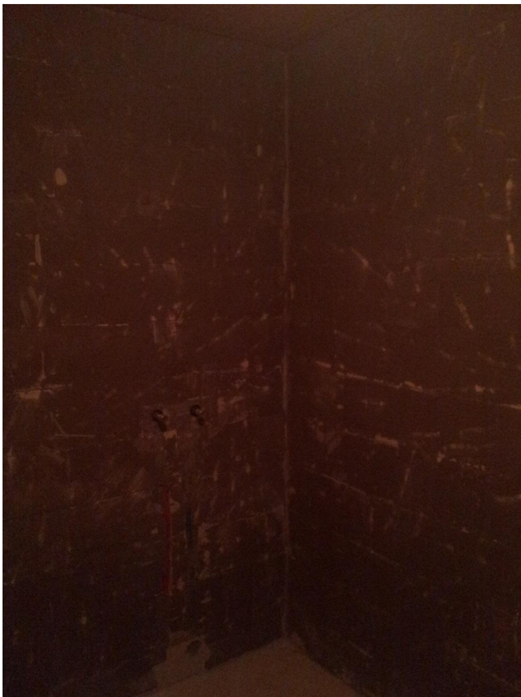
Kuva 1. Kylpyhuoneen seinät laattojen poiston jälkeen (Hanhinen Ville 2016)
