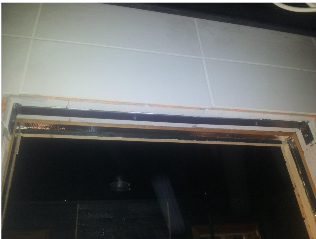
Kuva 5. Oven aukonylitys korjattu lattaraudalla (Hanhinen Ville 2016)
