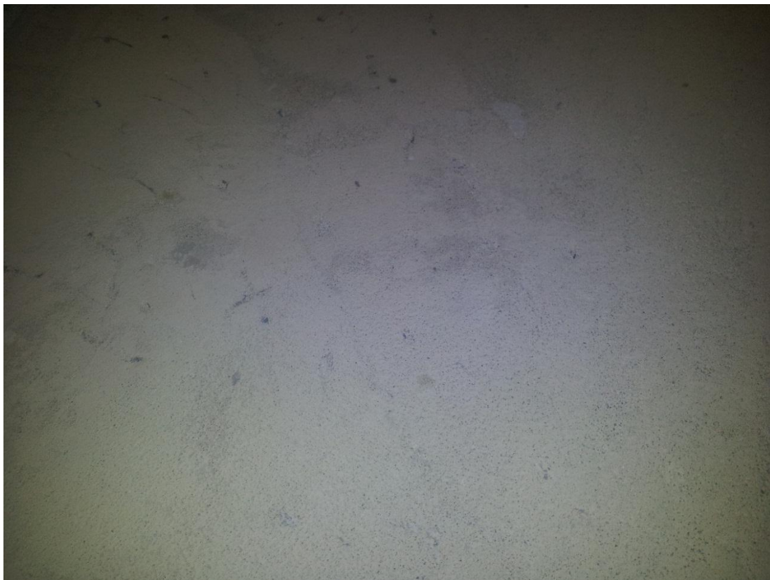
Kuva 13. Kylpyhuoneen lattia purkutöiden jälkeen ennen hiontaa. (Hanhinen Ville 2016.)
