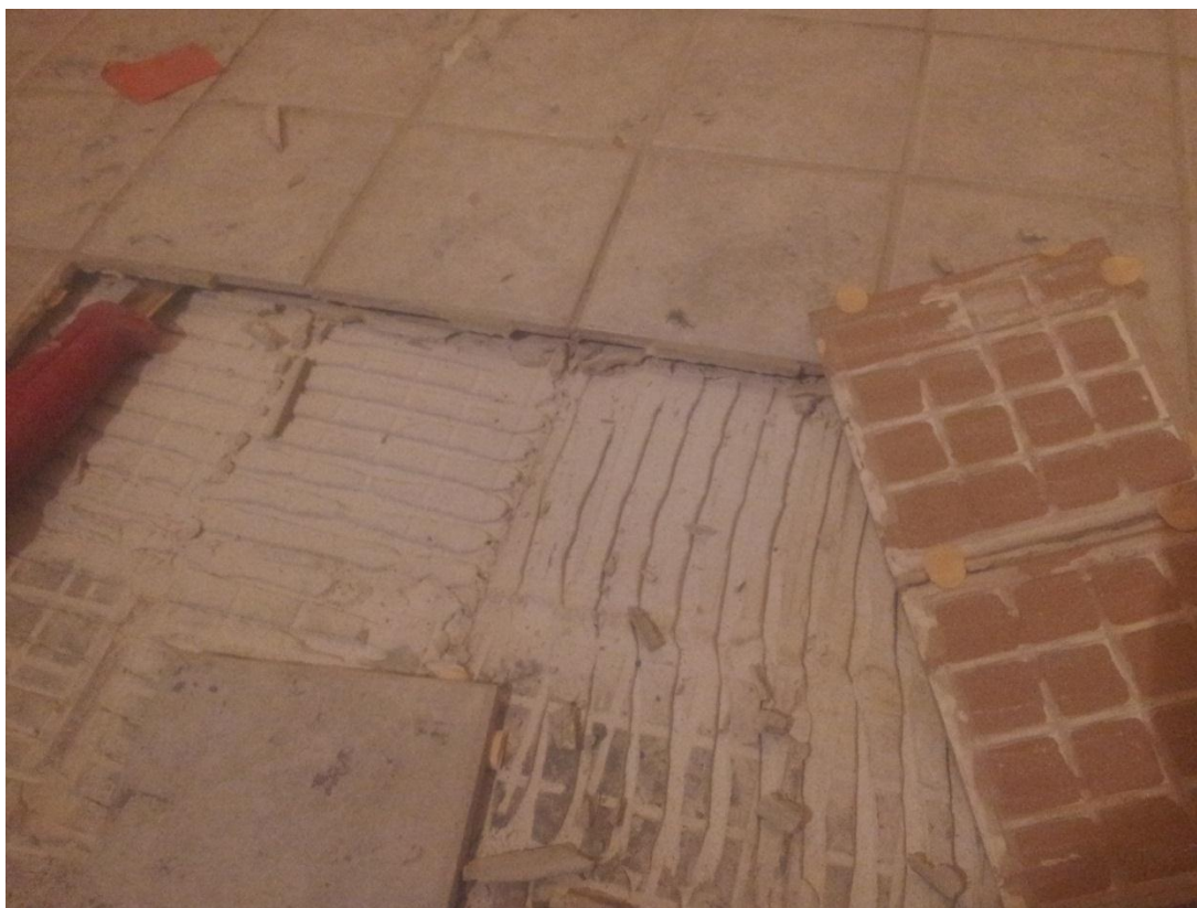
Kuva 12. Lattialaatat eivät ole tarttuneet kiinnityslaastiin nahkoittumisen takia. (Hanhinen Ville 2016.)
