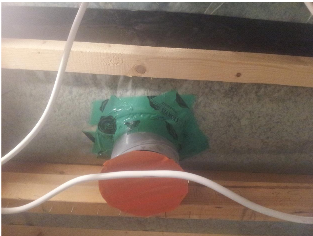
Kuva 10. Poistoilmakanavan tiivistyksen korjaus (Hanhinen Ville 2016.)
