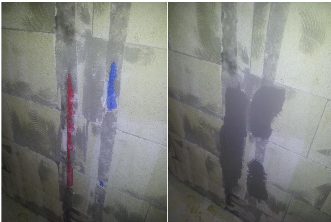
Kuva 6. Käyttöveden suojaputket ennen roilojen täyttöä ja täytön jälkeen (Hanhinen Ville 2016)
