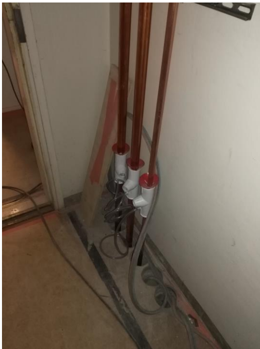
Kuva 2. Vesijohtonousut ja vuotovesisuppiloita asennettuna (kuva: Aleksi Hahto 2016)
