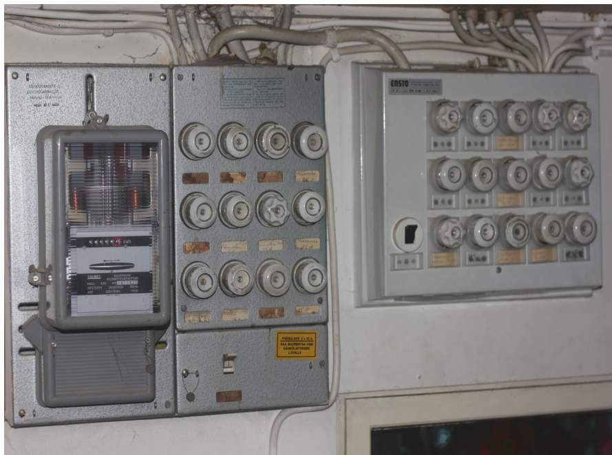
KUVA 1. Vanha pääkeskus ja sen laajennusosa
