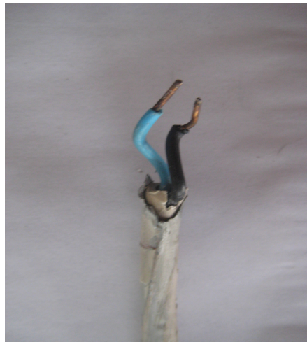
KUVA 4: Tyypillinen 1970-luvun loppupuolen alumiinivaippainen sähköjohto
