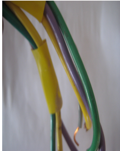
KUVA 5: Tyypillisiä sähköjohtimien värejä 1960-luvulla
