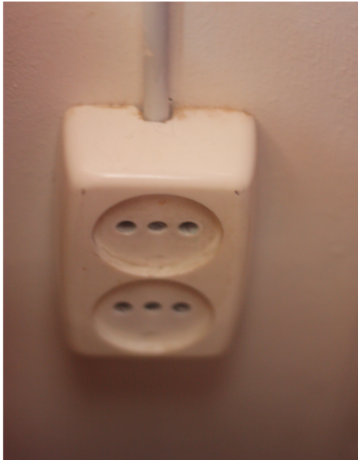
KUVA 20 Vanha maadoittamaton pistorasia
