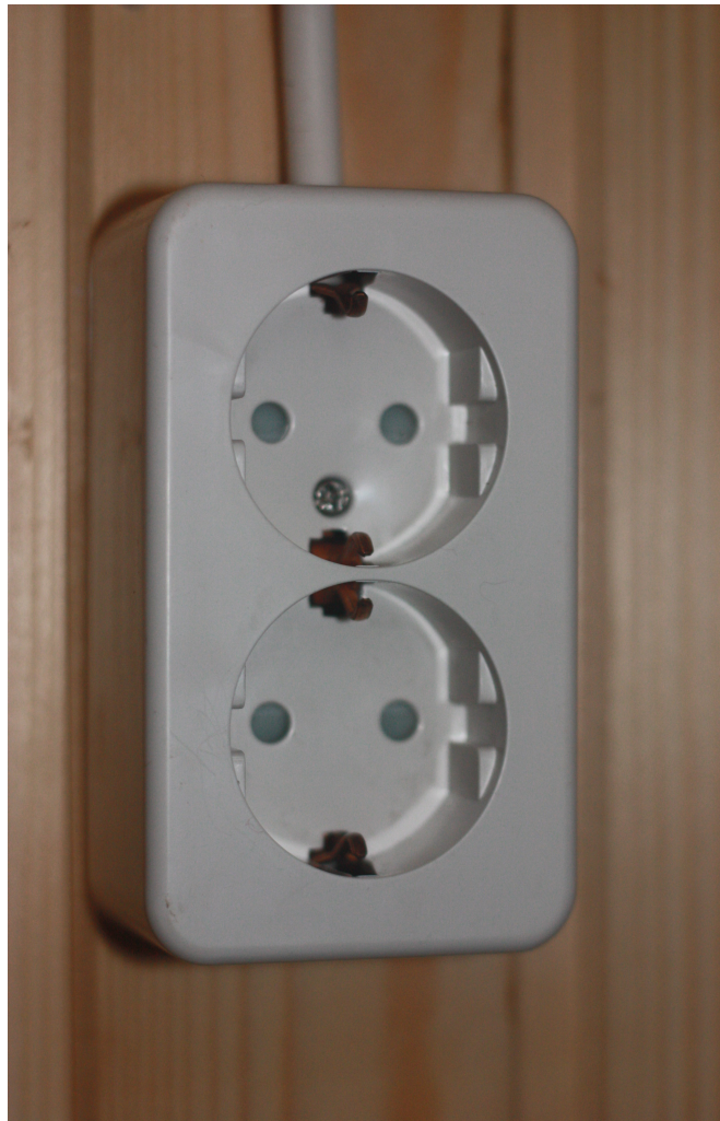
KUVA 21 Uusi maadoitettu suojakosketinpistorasia
