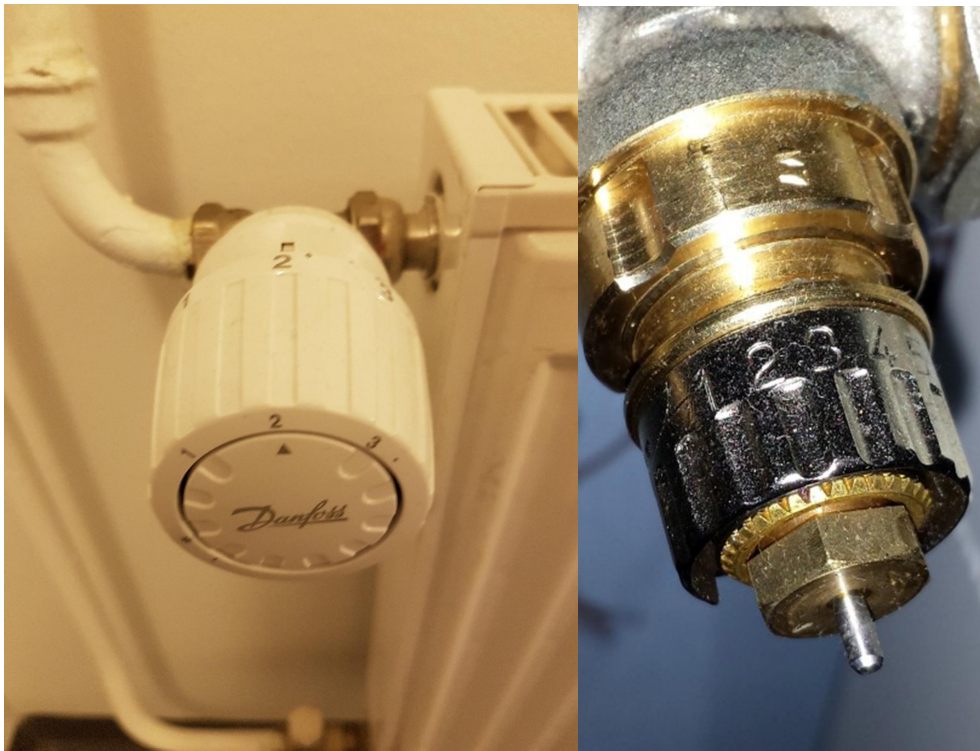
KUVA 7. Danfoss-termostaattiventtiili
