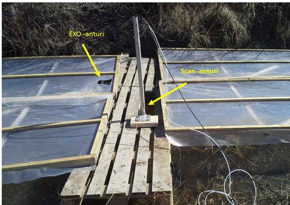
Kuvio 18. Scan- ja EXO-anturit 15.4.2016 asennettuna siltarakennelmaan mittauspaikalla (Alkuperäinen kuva Samuli Lahtela, muokattu)
