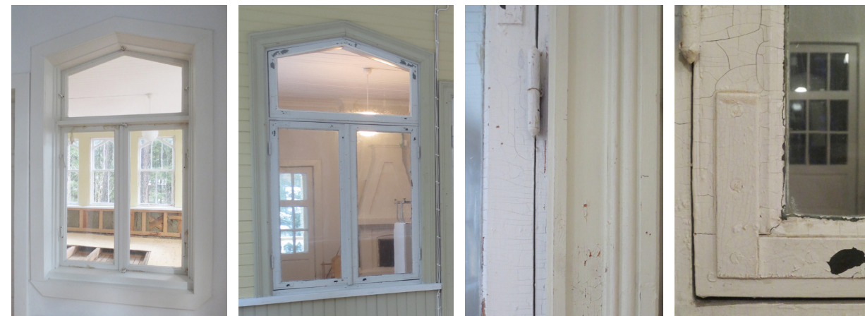
IK 2 huoneen 1 puolelta.
