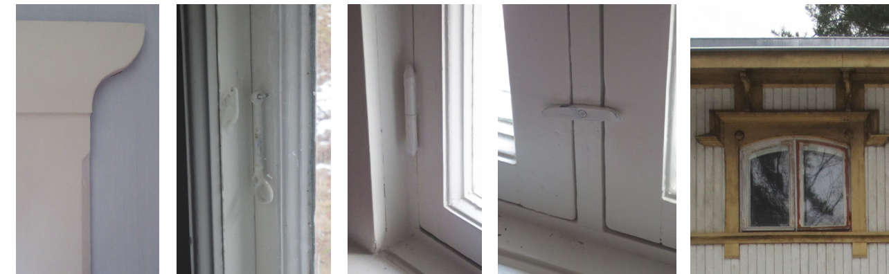
Vuorilistat on koristeltu. Myrskyhaka 1900-luvun alusta. Nostosarana on todennäköisesti alkuperäinen. Kääntösälpä. Ulkopuitteissa on punaista ja valkoista maalia.
