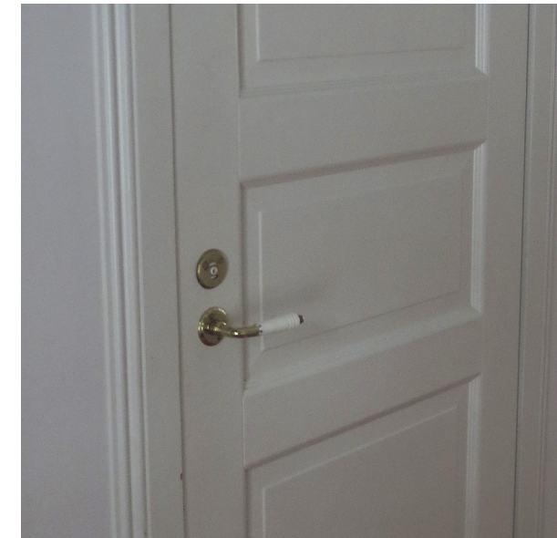
Ovi on hyvässä kunnossa.
