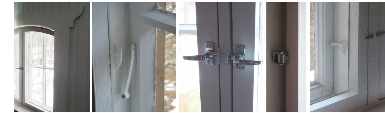
Vuorilistat on koristeltu. H4 puoleisen ikkunan myrskyhaka. H4 puoleisen ikkunan ikkunasulkimet ja viereisessä kuvassa sarana. Portaiden päällä olevan ikkunan sormihaka ja sulkijat.
