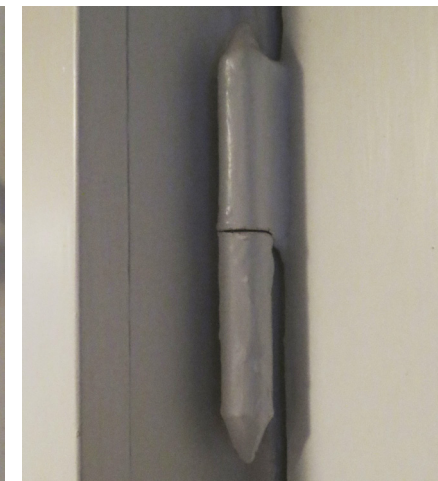
Kaikkissa ovissa on kartion malliset nosto-saranat joita alettiin valmistaa 1850-luvulla.
