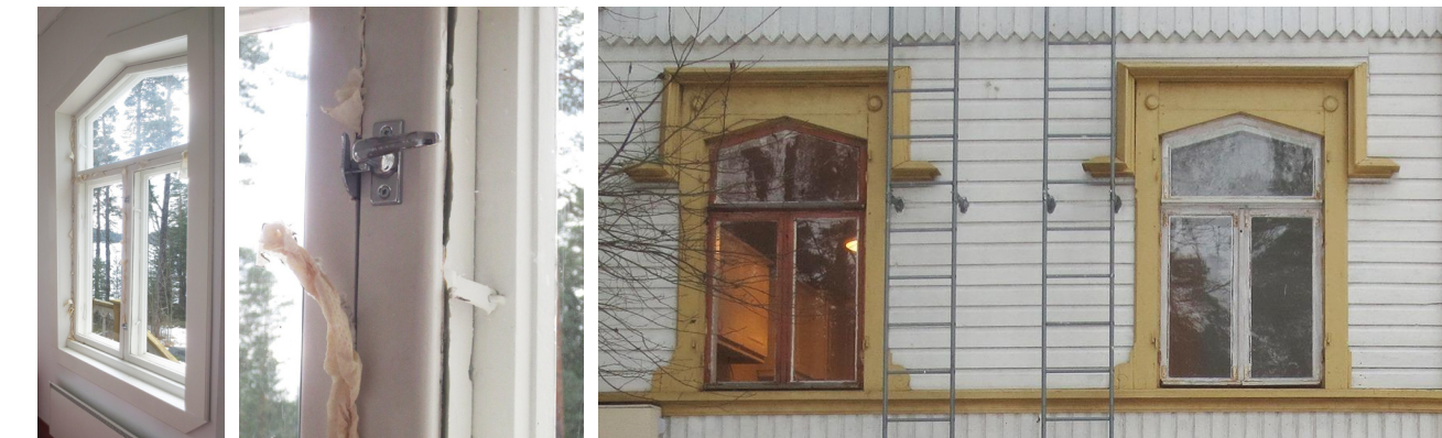
Ikkunoita on tiivistetty paperilla. Ikkunasuljin ja myrskyhaka. Vasemmalla keittiön ikkuna ja oikealla huoneen 2 ikkuna, jonka puitteet ovat poikkeuksellisesti valkoiset.
