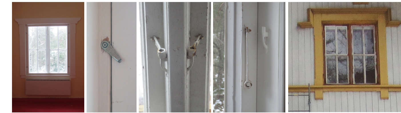
Vuorilistat on koristeltu. Ikkunasulkija on todennäköisesti uudempi kuin ikkunan muut helat. Sormihakojen ja viereisessä kuvassa samaa sarjaa oleva myrskyhaka. Huoneen 3 ikkuna ulkopuolelta kuvattuna.
