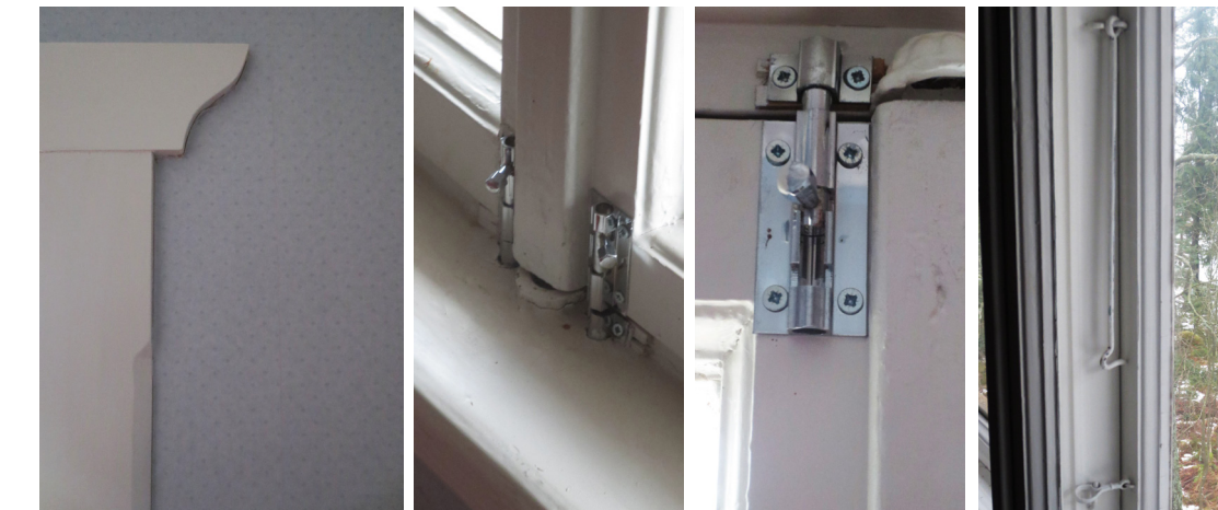
Vuorilistojen muotoilu muistuttaa työntösarpoja ikkunan ala- ja yläpökissa. Sormihaka ja pitkä ikkunahaka.
