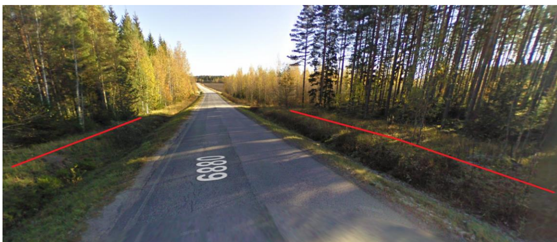
Figur 1, Exempel på kabeldragning vid landsvägsområde
