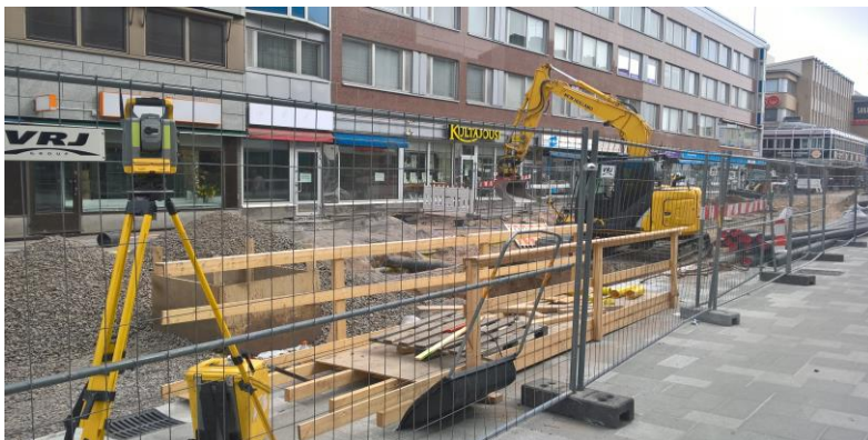
Kuva 3. Takymetri mittausvalmiina Kouvolan keskustan saneeraustyömaalla.
