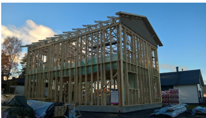
Kuva 8. Paikalla rakennettava omakotitalo runkovaiheessa.
