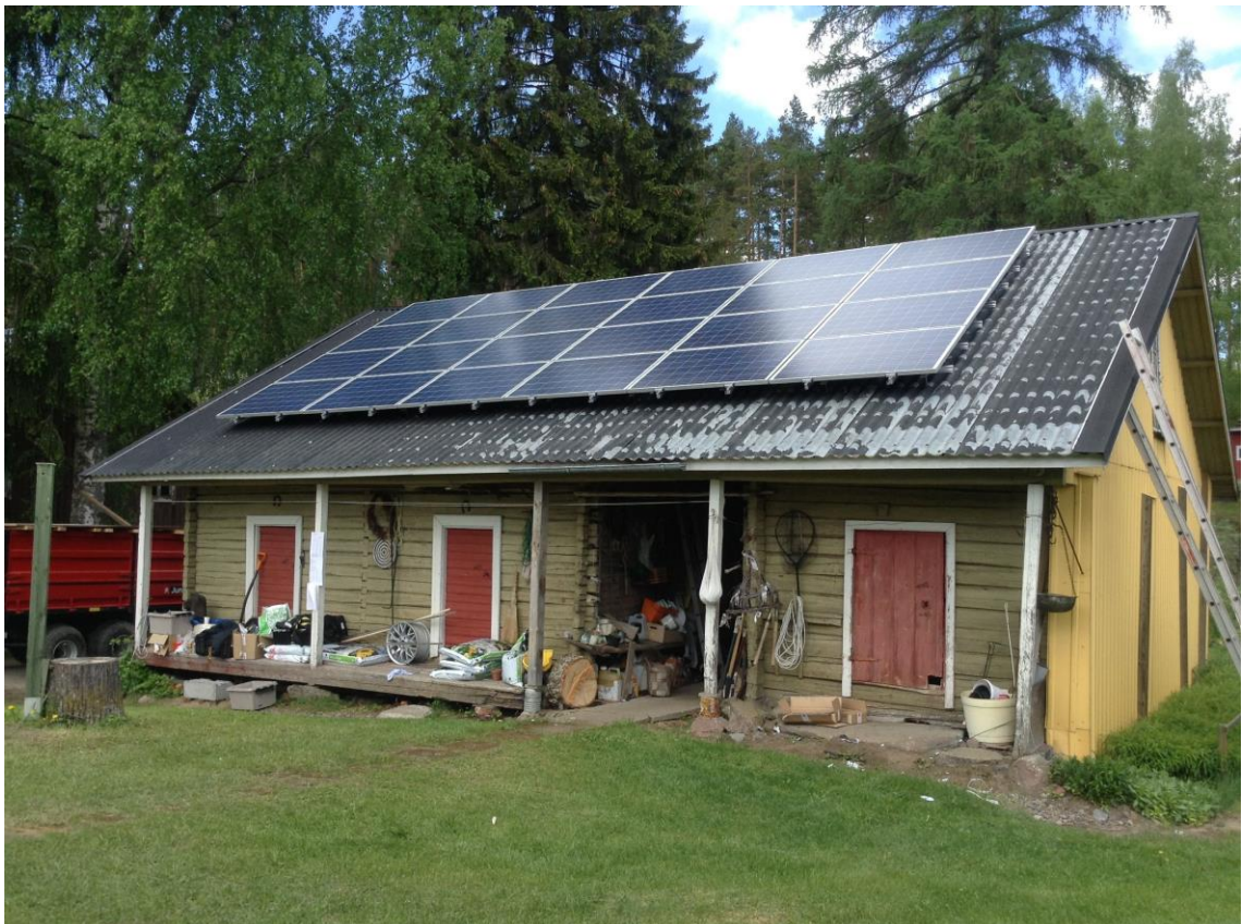
Kuva 2. Aurinkokennot asennettuina omakotitaloon (25)
