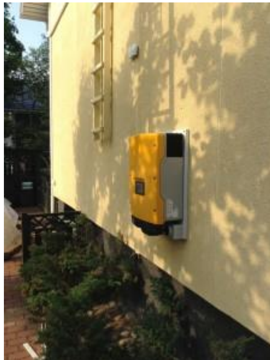
Kuva 8. Ulos asennettu invertteri (22)
