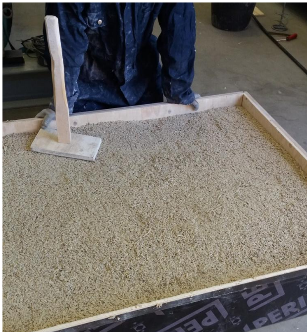
Kuva 15. Tiivistetty hammppubetoni muotin sisällä. (Kuva: Pajukoski 2016)
