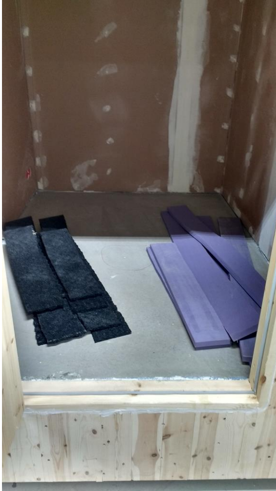
Kuva 9. Eristematot valmiiksi suikaleiksi leikattuna. Tuotenimikkeet Regupol® (kuvassa musta eriste) ja Regufoam® (kuvassa violetti eriste), valmistajana BSW Berleburger Schaumstoffwerk GmbH.
