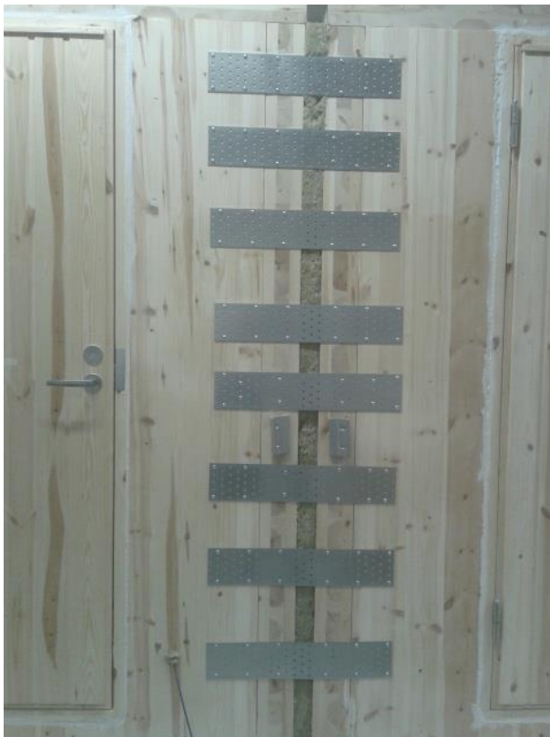
Kuva 7. Metallisia kiinnikelevyjä kiinnitettynä elementtien välille.
