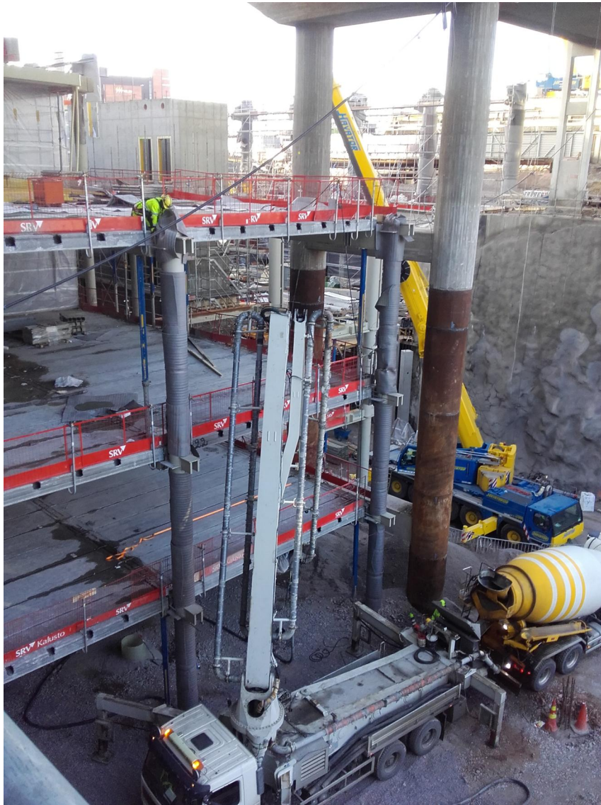
Kuva 19. CFT-pilarin betonointi kauppakeskus RED1 :n työmaalla Helsingissä 16.02.2017 [33].
