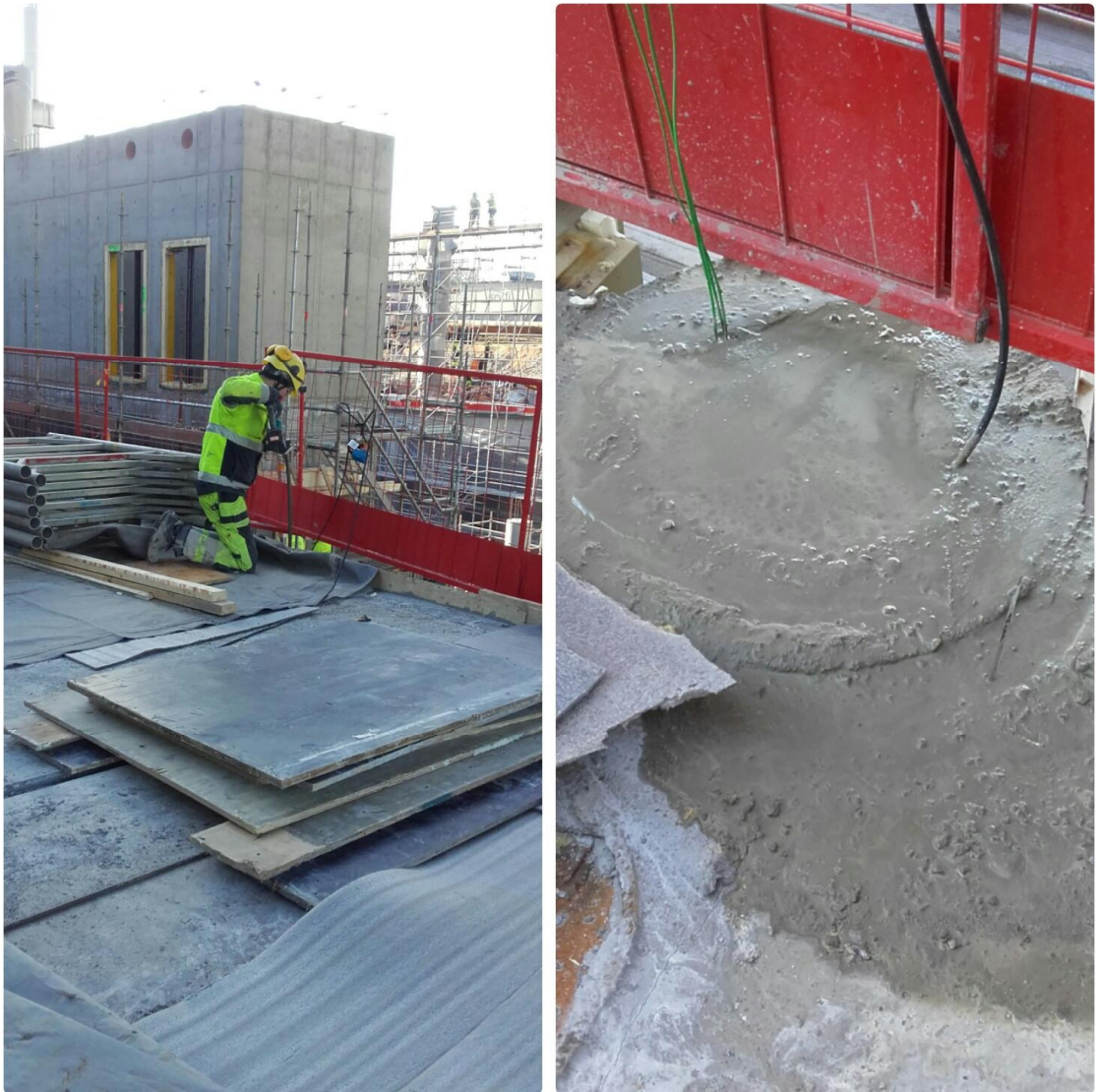
Kuva 21. Betonimassa jälkitärytetään sauvatäryttimellä CFT-pilarin yläpäästä ja ylimääräinen betoni siistitään pilarin päältä pois [35].
