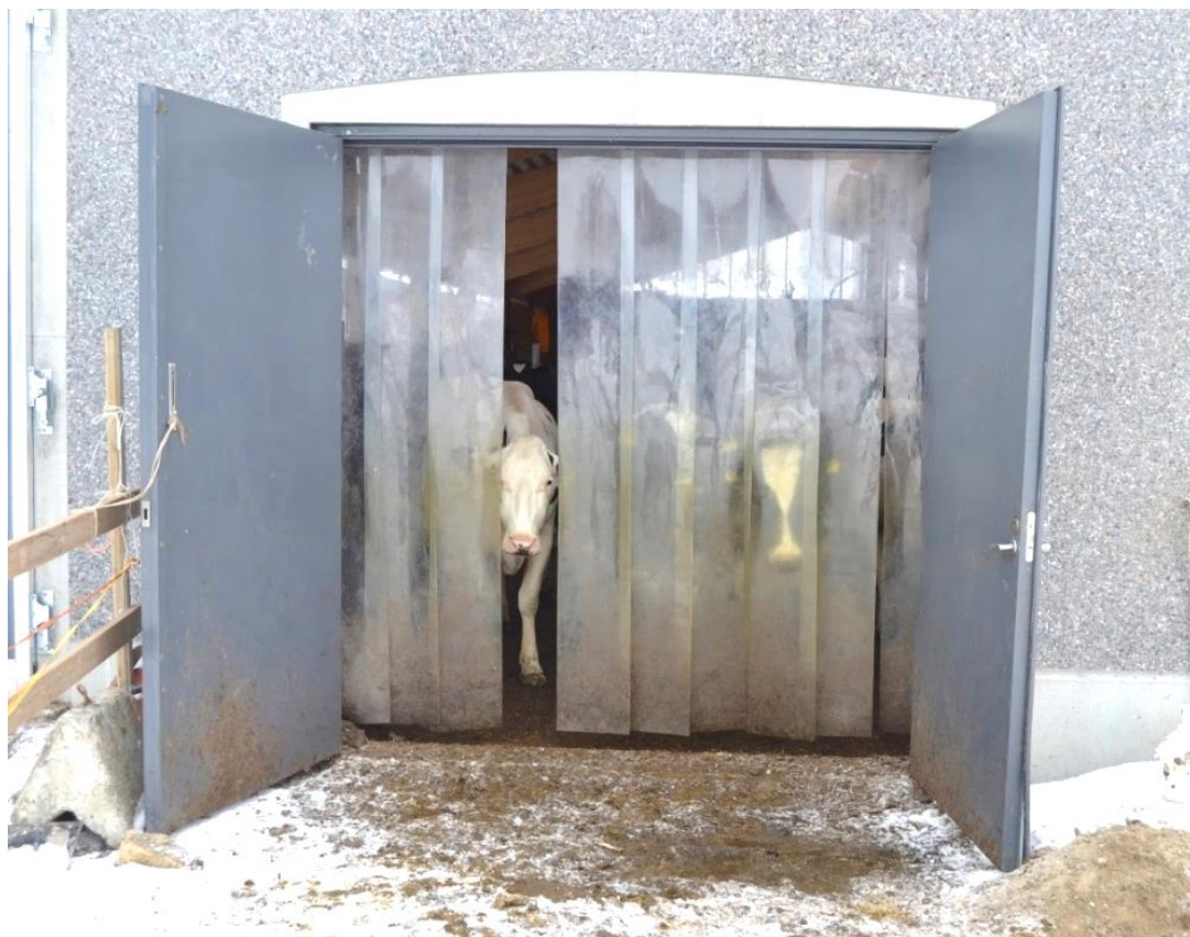
KUVA 8. Lintujen sisään pääsemisen estämiseen tarkoitettu muoviliuskaverho ulko-oven edessä (Rönkkö 2017-04-15).
