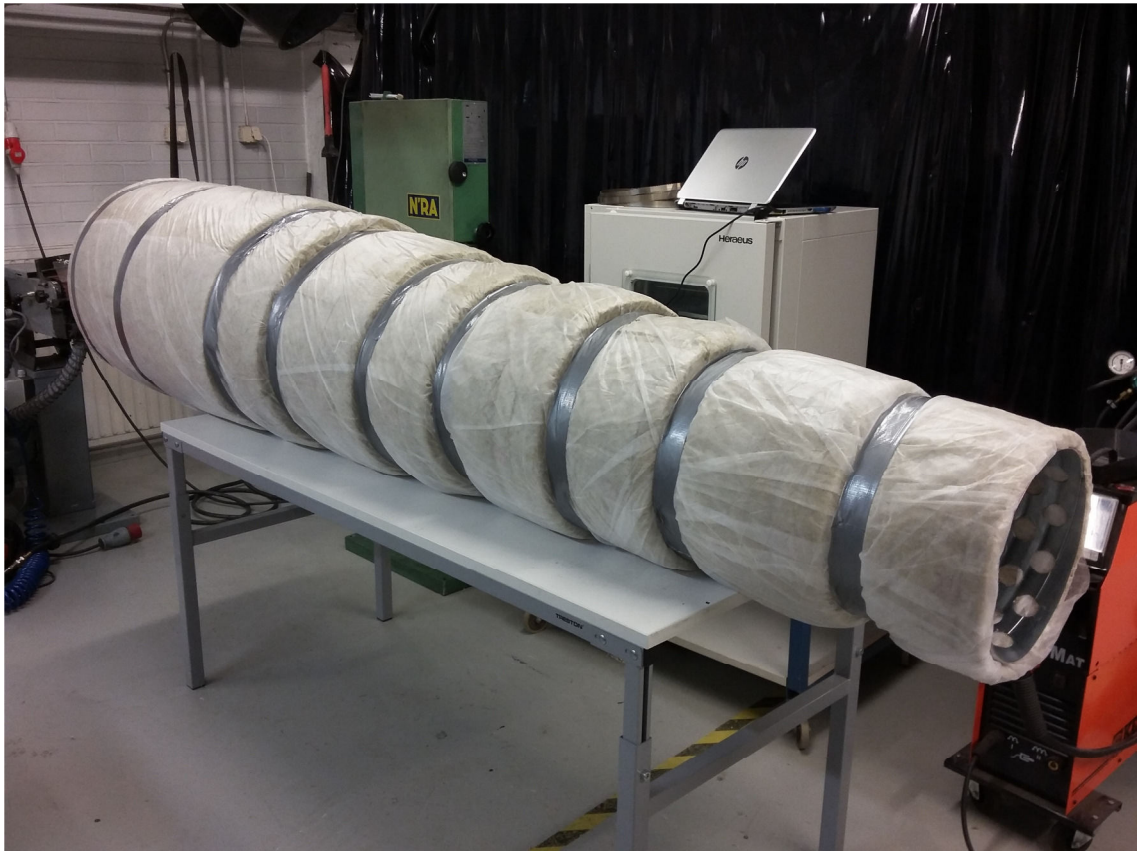
Kuva 19. Valmis eristetty ja harsoitettu kaiun poisto.
