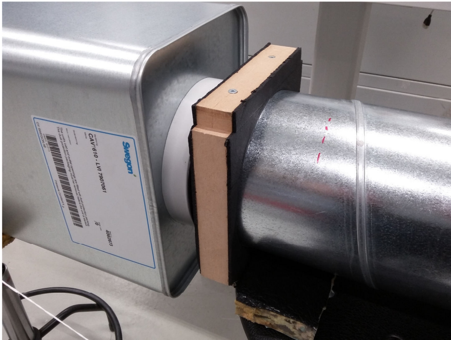
Kuva 20. Vaimentimen ohi kulkeutuvan melun selvittämiseksi kanava tukittiin ennen vaimenninta (limiting insertion loss [1, s. 37 – 39.]) Mittauksen tulos löytyi liitteestä 5.
