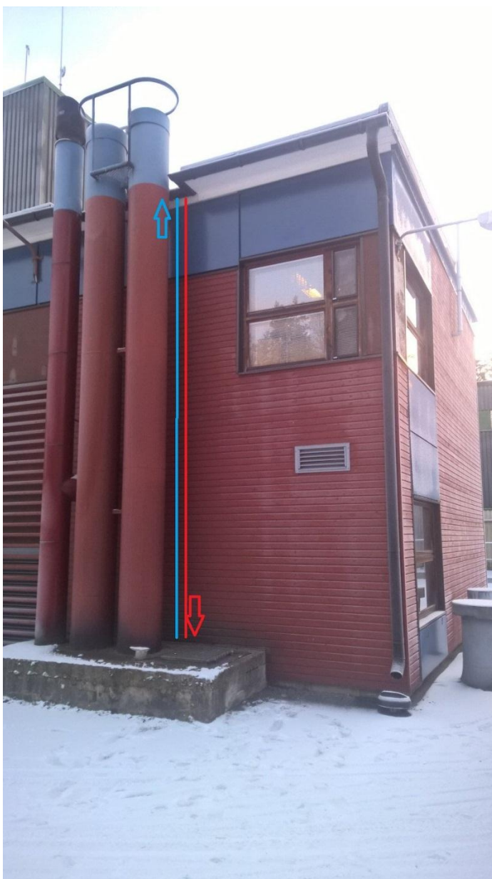
Figure 25 Esimerkki lämmönsiirtoputkien viennistä katolle
