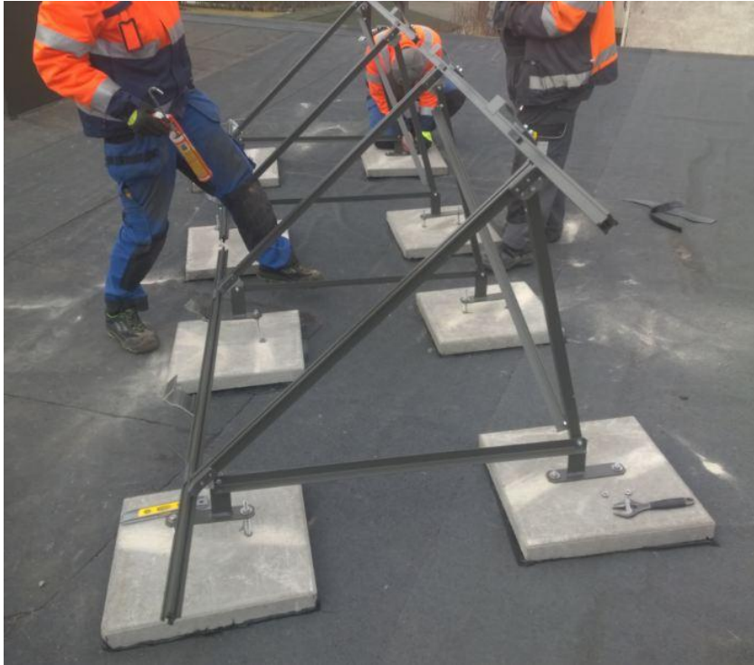
Figure 16 Esimerkki telineitten asennuksesta (Solarleap-projekti)
