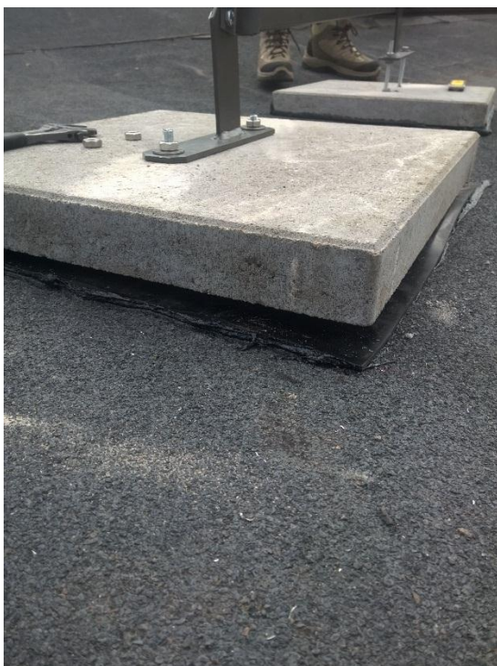
Figure 21 Tiiviste- ja ankkurointimassa (Solarleap-projekti)
