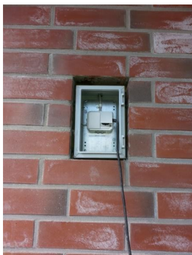
KUVA 5. Ulkopistorasia kotelossaan (Honkanen 2016.)
