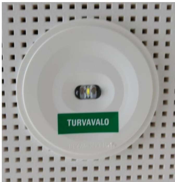
KUVA 16. Turvalaisin upotettuna alakattolevyyn (Honkanen 2016.)
