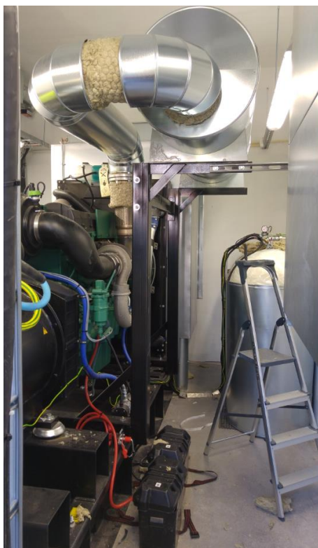
KUVA 30. Dieselmäärän asennustyöt meneillään (Honkanen 2016.)
