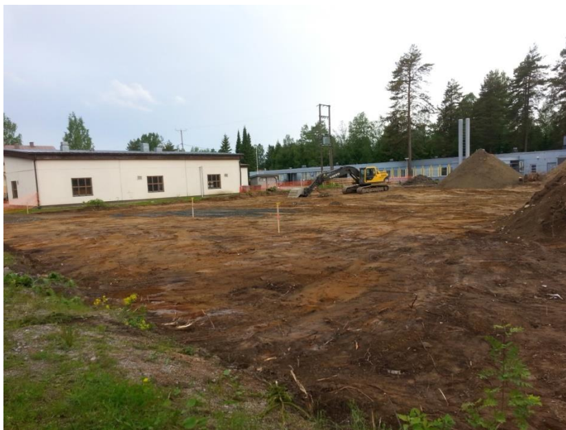
KUVA 1. Maanrakennustyöt vauhdissa (Valtimon sähkötyö Oy 2015)
