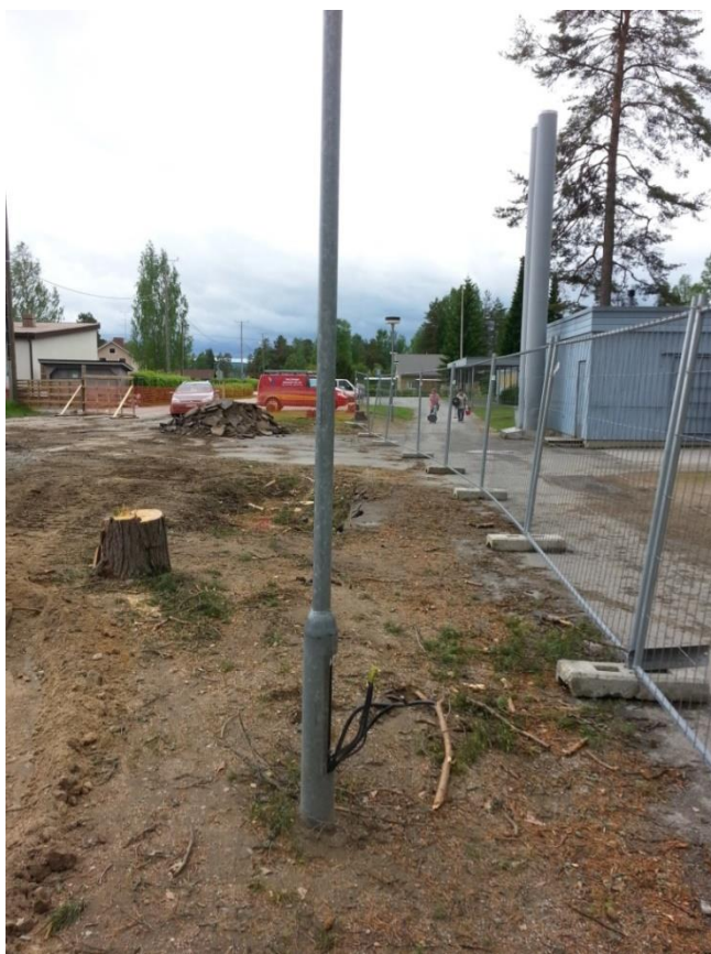
KUVA 2. Vanha pihavalaisin purettuna (Valtimon sähkötyö Oy 2015)
