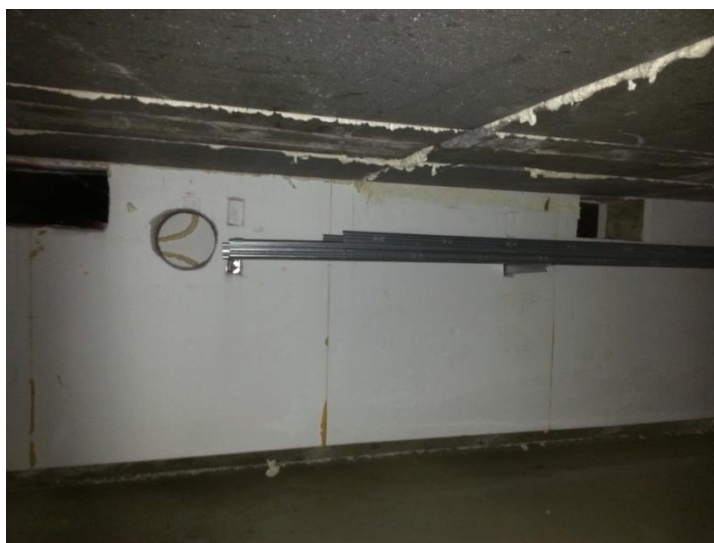
KUVA 6. Kaapelihyllyt ryömintätilassa (Valtimon sähkötyö Oy 2015)
