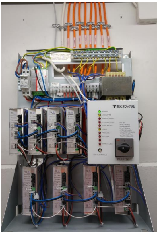
KUVA 17. Turvalokeskus akkuineen (Honkanen 2016.)
