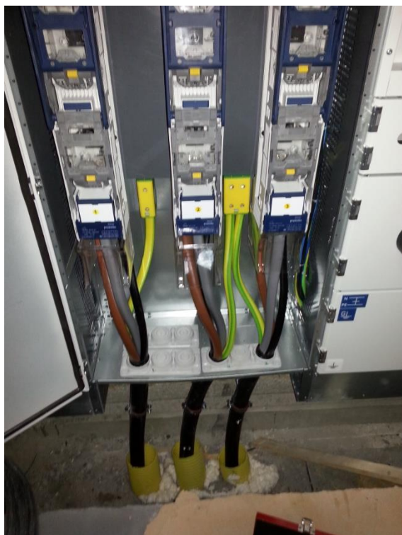
KUVA 11. Liittymisjohdot kytkettyinä pääsulakkeille
