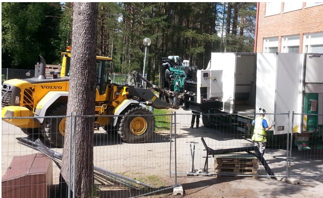
KUVA 29. Dieselmäärän nosto varavoimakonehuoneeseen (Valtimon sähkötyö Oy 2016.)
