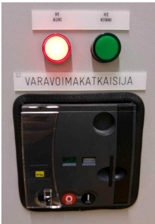
KUVA 24. Varavoimakatkaisija Q2 (Honkanen 2016.)
