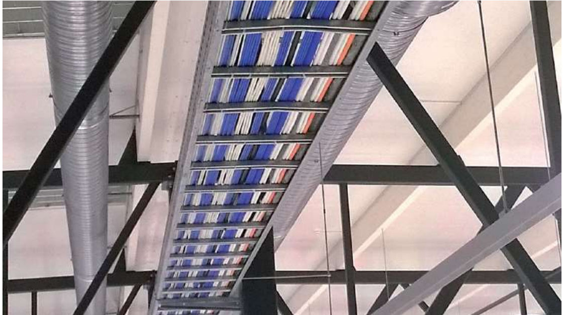
Kuvio 3. Esimerkkikuva sopivasti täytetystä hyllyasennuksesta (ST 51.13, 2014).
