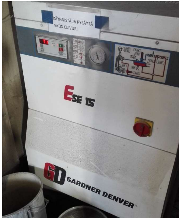
Kuvio 8. Yksi Jetta-Talon paineilmakompressoreista
