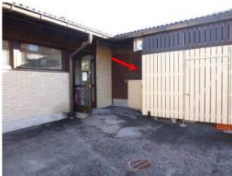
Kuva 7. Päiväkodin ilmanvaihdon tuloilman ottoipaikka merkitty punaisella nuolella (Insinööritoimisto Levola 2014).
