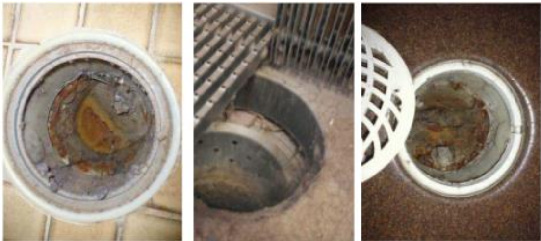
Kuva 6. Kohteen lattiakaivoja (Insinööritoimisto Levola 2014.)
