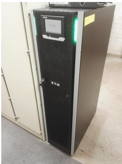
Kuva 13. Eaton 93PS 10kVA. Kuvasta erottuvat LCD-näyttö sekä käytössä oleva LED-tehonäyttö (Santeri Kedonperä, 2017)
