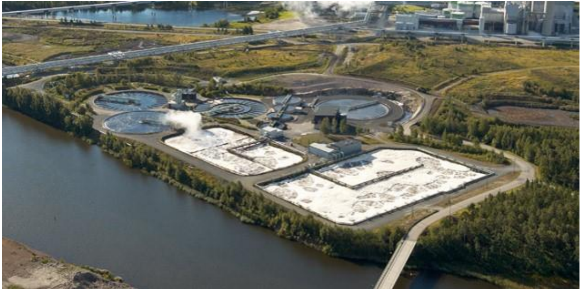
Kuva 2 Jätevedenpuhdistamo (UPM Paper ENA, valokuva-arkisto).
