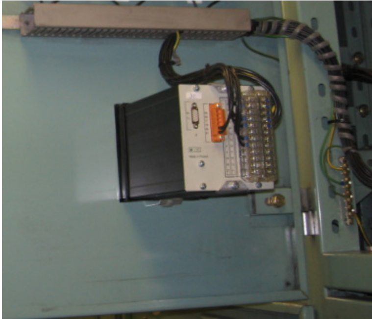
Kuva 5. Releen oikeaoppinen uppoasennus kojeiston kanteen
