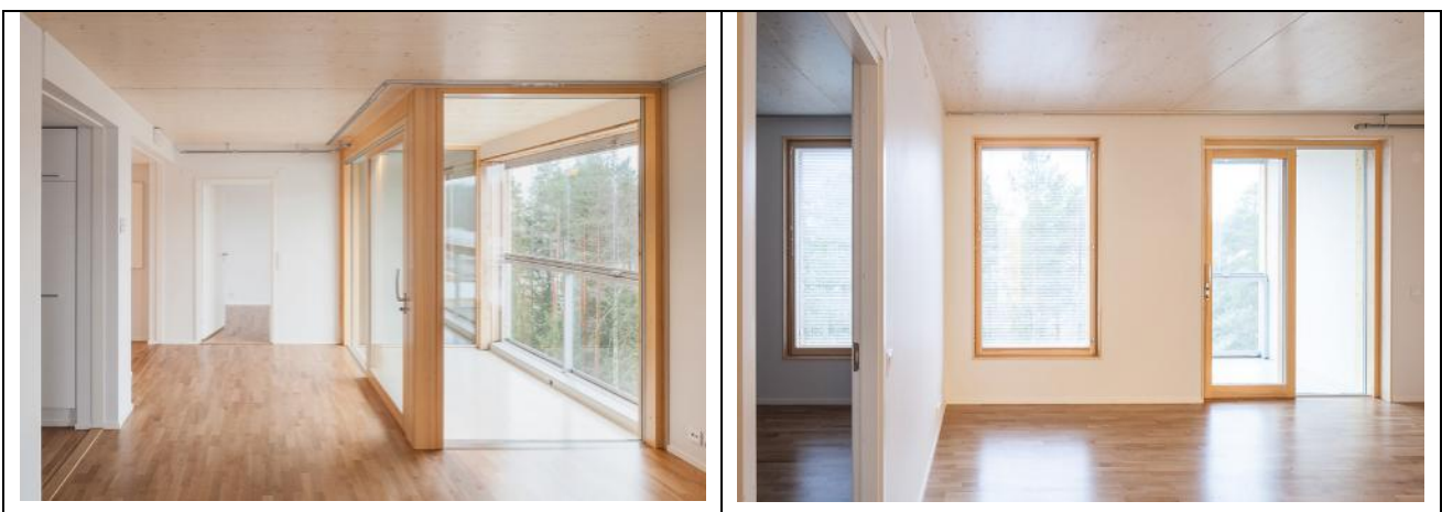
Kuva L3-2. Puukuokan sisätiloja, joissa alakattoja CLT levy. (Kuvat Mikko Auerniitty)
