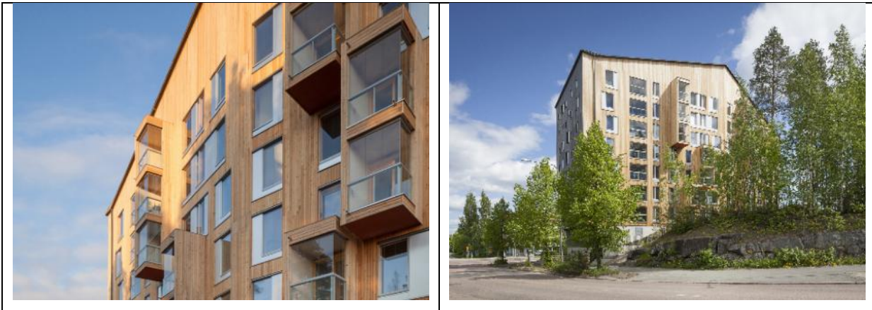
Kuva L3-1. Puukuokan puujulkisivuja. (Kuvat Mikko Auerniitty)
