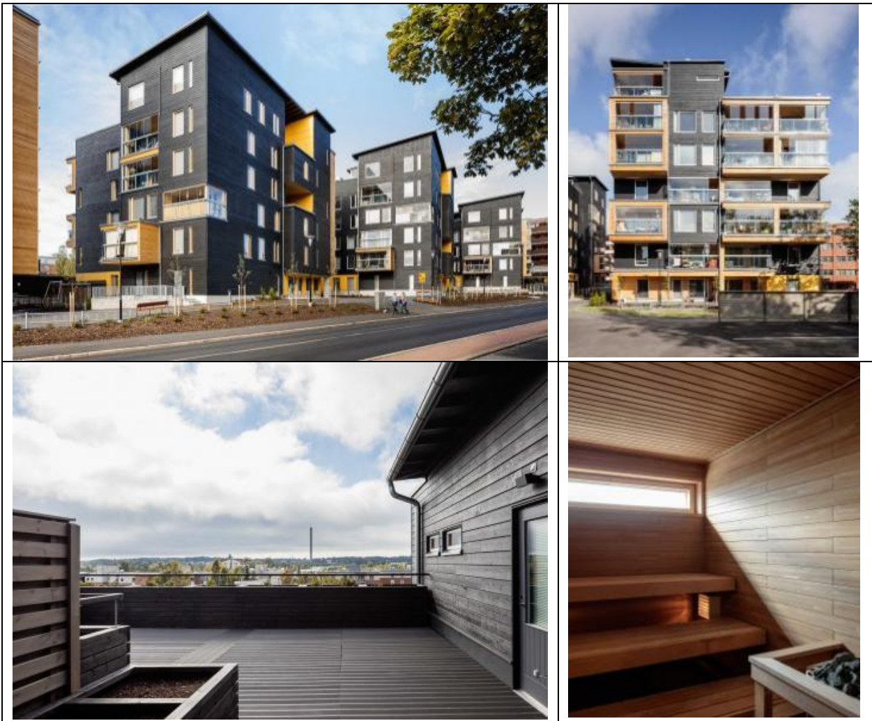
Kuva L3-4. Eskolantien rakennusten julkisivuja, terassi ja sauna. ( Kuvat: Tuomas Uusheimo)
