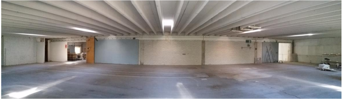
Kuva 7. Hallin C, 545,6 m 2 , väliseinällä sijaitsevat liukuovet, jotka toimivat myös palo-ovina.
